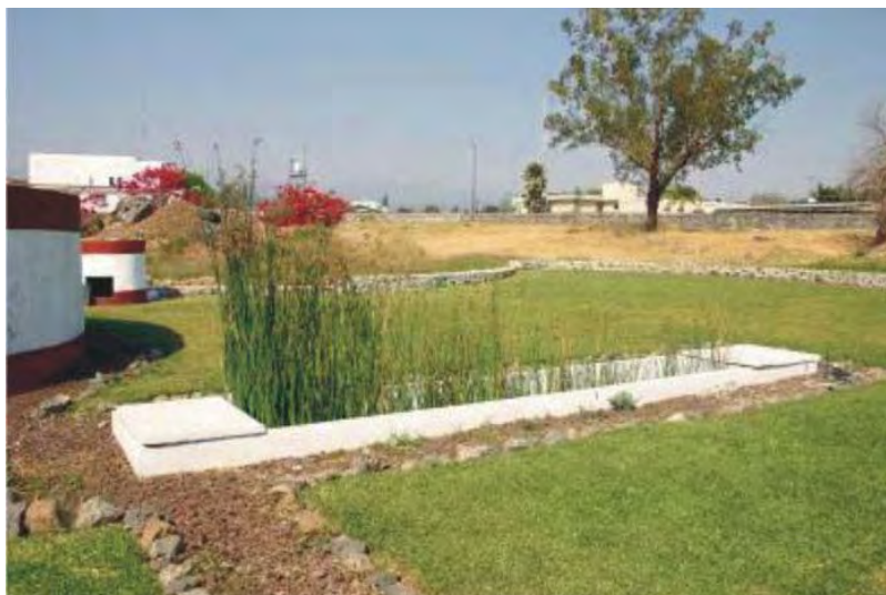
Biofiltro y humedal para tratamiento de agua residual
