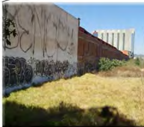
Colindancia con Hotel (Oeste)
