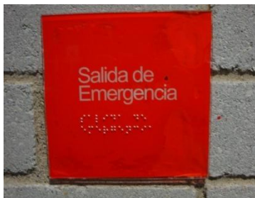
Señalización en braille
