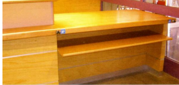
DETALLE DE UN MOSTRADOR ACCESIBLE VESTÍBULO DEL HOSPITAL UNIVERSITARIO DE GETAFE.
