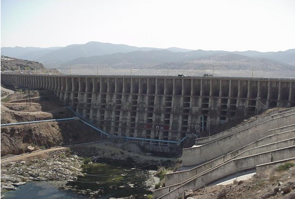
Figura 4.2 c) Cortina de machones tipo Ambursen, y obra de excedencias de la presa Abelardo Rodríguez B.C.
