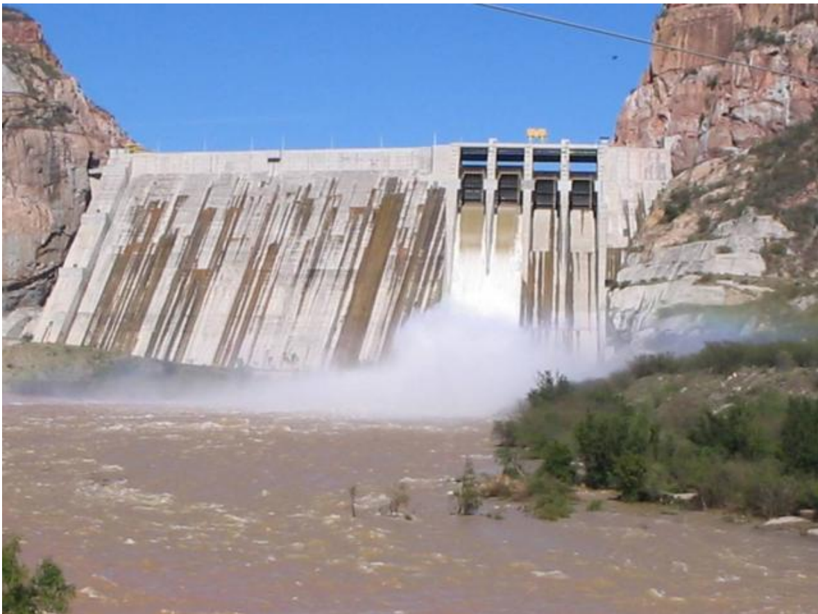
Figura 3.4 b) Huites, cortina tipo gravedad en combinación con la cortina de arco
