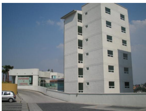
Fig III.11 Vistas de la Herradura Edificio 5.
