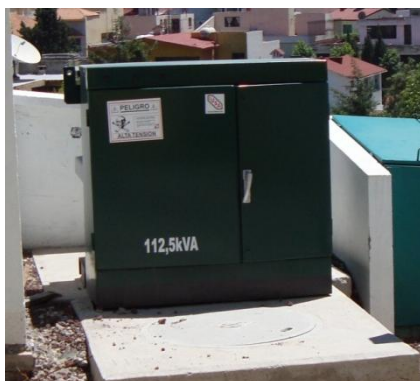
Fig. III.12 Transformador, Vistas de la Herradura.
