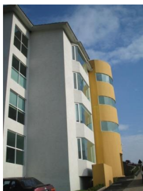
Fig III.7 Vistas de la Herradura Edificio 4
