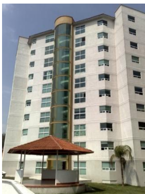
Fig III. 9 Vistas de la Herradura Edificio 6.
