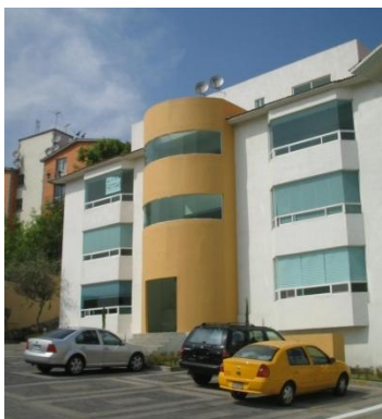
FIG III.5 Vistas de la Herradura Edificio 1.
