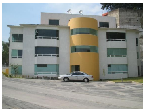
Fig III.6 Vistas de la Herradura Edificio 2.
