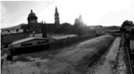
FIG.III.153. Azotea de la cárcel que denota la bóveda de cañón corrido. Foto. JGGB.
