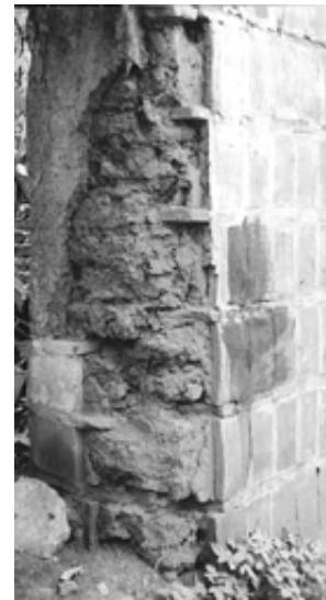
FIG.III. 119 y 120. Fragmento de la lámina 1 con el muro emplecton del Compendio de los diez libros de arquitectura de Vitruvio por Claudio Perrault y vista de un muro emplecton.
