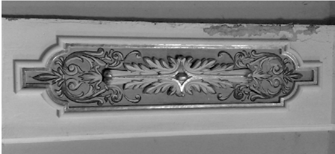
FIG.III.61. Vista de un panel en los arcos torales. Foto JGGB.
