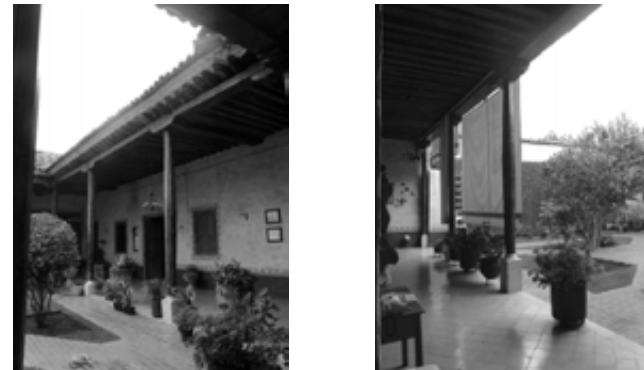
FIG.III. 122 y 123. Vistas de la Casa Manzo Maldonado en Cotija de la Paz construida con las métodos tradicionales de la región, las columnas, zapatas, gualdras y vigas de madera.
