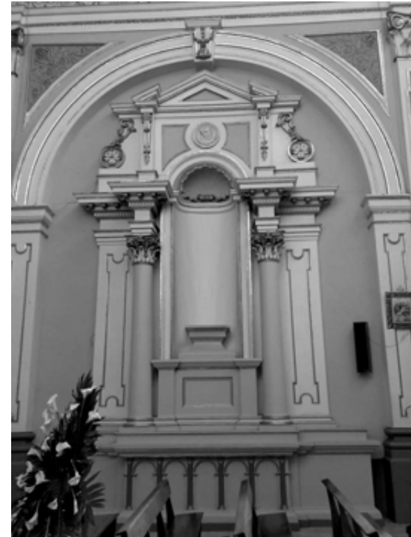
FIG.III.42. Altar del “Ecce Homo” formado por un nicho central apoyado en un banco y rematado con un arco flanqueado en un primer nivel por dos columnas compuestas y dos pilares que soportan un ático limitado a cada lado por modillones. En el ático hay dos ménsulas que sostienen un frontón. Foto JGGB.
