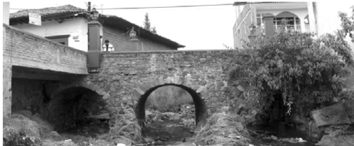
FIG.III.88 y 89. Vista norte y sur del puente sobre el Río Cotija. Calle Miguel Hidalgo. Foto.JGGB.
