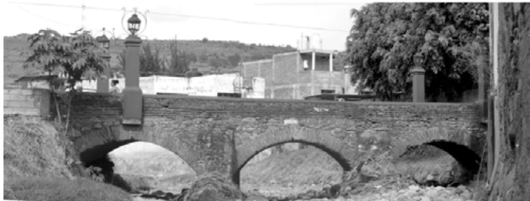
FIG.III.92 y 93. Puente sobre el Río Cotija. Calle Pino Suárez.
