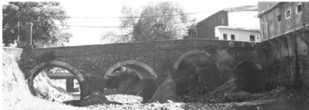
FIG.III.83 y 84. Vistas oriente y poniente del puente sobre el Río Cotija. Calle Francisco Javier Mina. Fotos JGGB.
