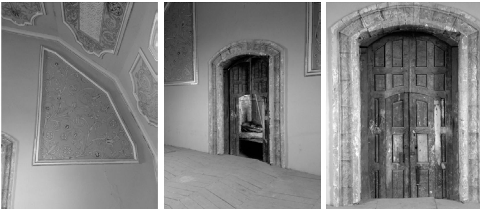
FIG.III.52.53. y 54. En la primera imagen vista de uno de los tableros imitando lienzos de mármol, en la segunda, vista del coro al balcón del nártex y en la tercera la puerta en dos hojas de tableros con postigo. El marco de cantera es otro trampojos, esta policromado imitando un acabado marmoleado. Fotos JGGB.
