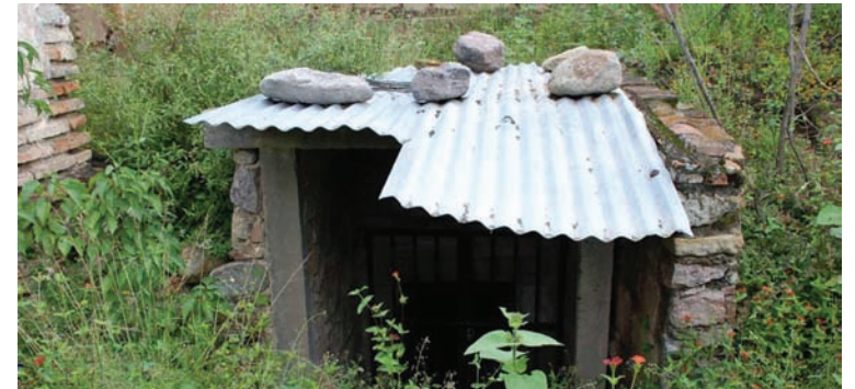
Fig. 25 La entrada al recinto bajo tierra
