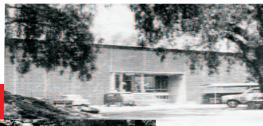
Imagen del actual edificio 1, originalmente Biblioteca
