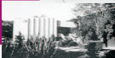
Edificio 1 de Dirección
