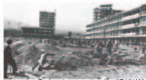
Explanada en construcción. IIE UNAM. Foto Guillermo Zamora.
