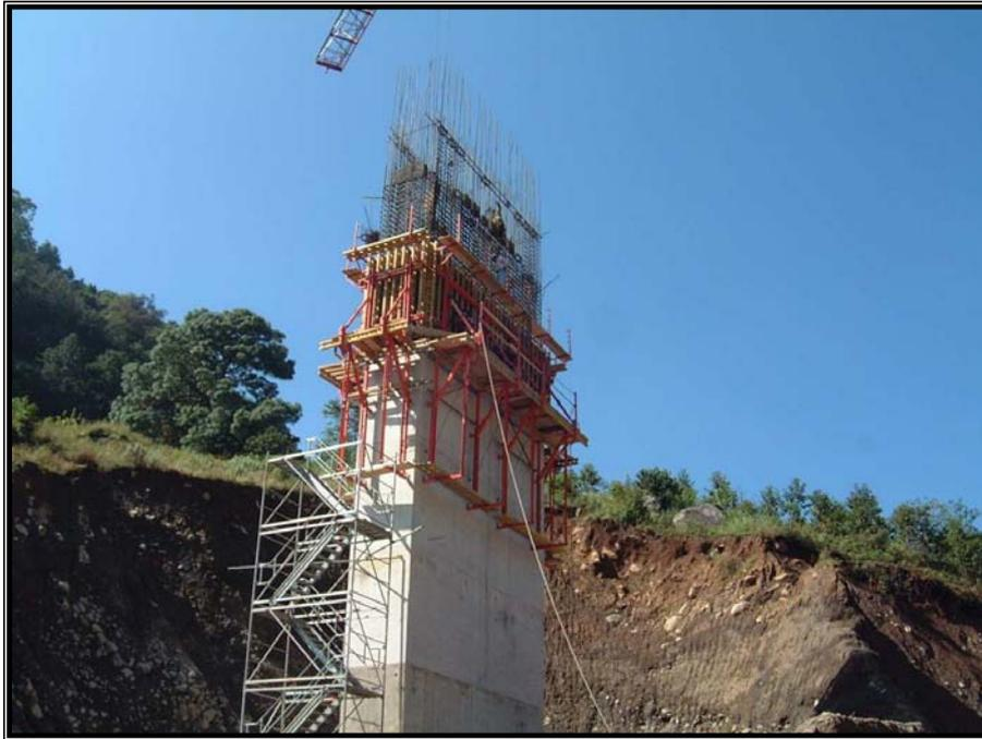
*FIGURA 26. CIMBRA TREPADORA COLOCADA EN PILA.*
