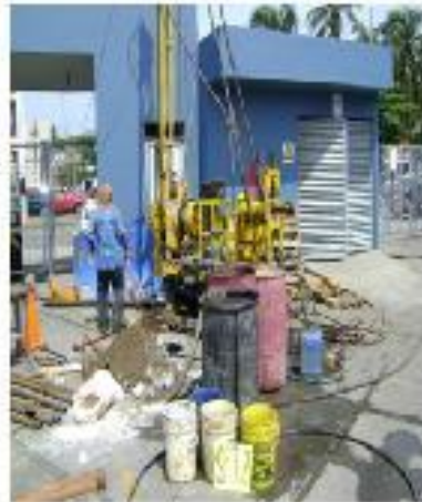
TRABAJADOR EN EL SITIO DE TRABAJO CON UNO DE LOS TUBOS DE 30 CM DE Ø.
