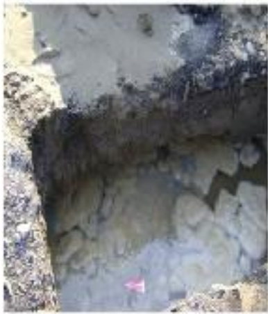
7.3.2.4. HUECO DE LA CIMENTACION EN EL FONDO DEL TRENCH EN LA BARRERA.
