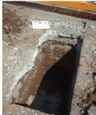
4. HUECO EN PAVIMENTO DE CONCRETO EN LA CALLE DE LA FERIA, EN EL PASEO DE LA FERIA, EN EL MUNICIPIO DE ARAGÓN, ESTADO DE MÉXICO.
