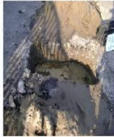
7.3.2.3. HUECO DE LA CIMENTACION EN EL FONDO.
