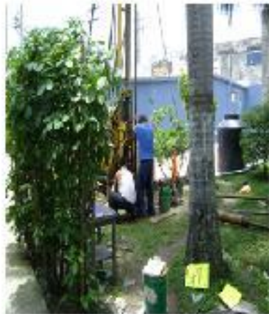
TRABAJO DE LA TORRE DEL CRANEO EN EL AREA DE LA TORRE 24
