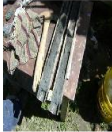
CONSTRUCCION DE BARRERAS PARA EL PASILLO
