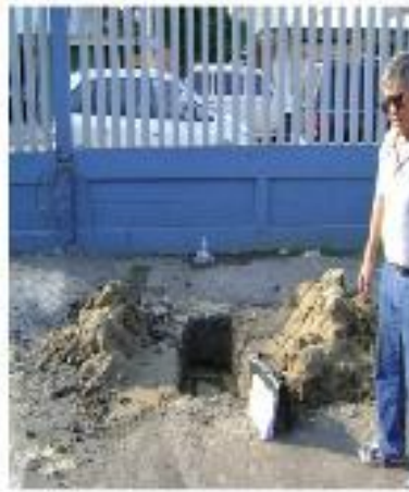
7.3.2.5. HUECO DE LA CIMENTACION EN EL FONDO.
