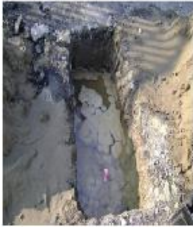
7.3.2.2. HUECO DE LA CIMENTACION EN EL FONDO DEL TRENCH EN LA BARRERA.
