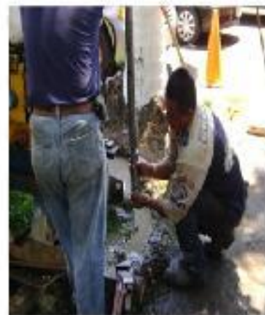
TRABAJO DE REPARACIÓN DE LA PARED DE CONCRETO Y REFORZAMIENTO DE LOS CIMENTOS DE LA SPT 4.
