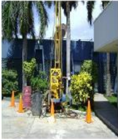
REPOSICION DE LA TORRE DEL CRANEO EN EL AREA DE LA TORRE 24
