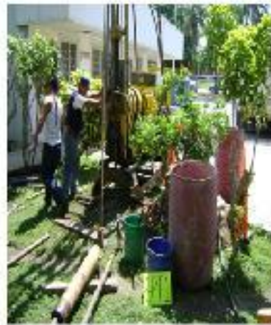
ÁREA DE ALMACÉN DE MATERIALES
