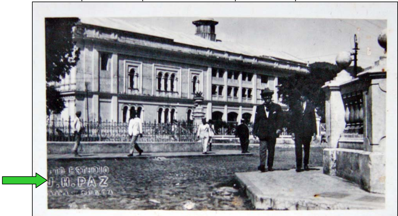
Imagen 4. Detalle de la fotografía 1. San Salvador, C. A. que muestra la presencia de manchas por deterioro químico.
