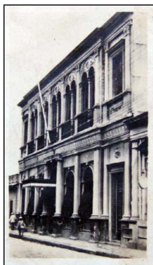
Imagen 44. 21. Casino Salvadoreño (Entre los parques)
