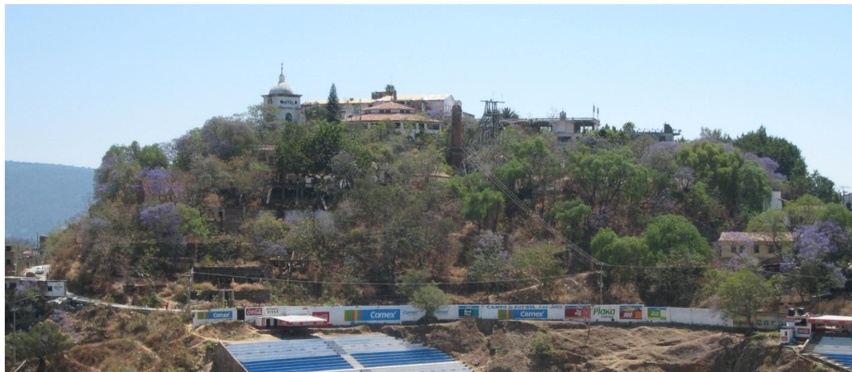
Vista panorámica del terreno.
