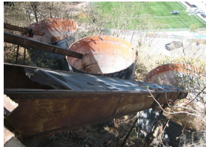
Tres silos metálicos usados para granos.
