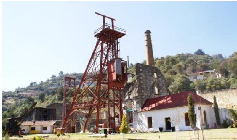
Vista del tiro de la mina
