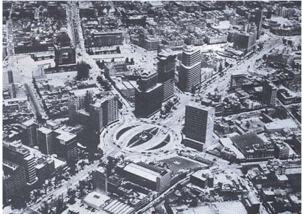
Imagen aérea del paseo de la Reforma de 1950
