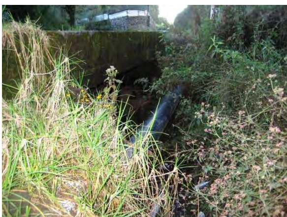
Imagen 3.8. Tubería de acero en cauce.
