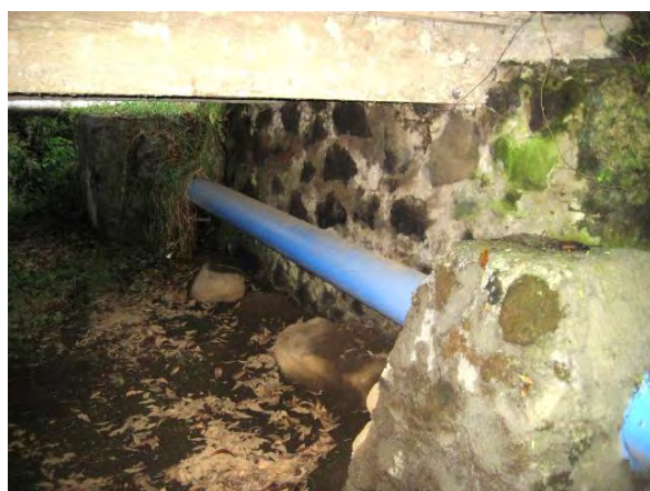
Imagen 3.9. Atraques en tubería de acero.
