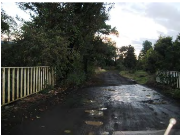
Imagen 3.6. Puente sobre cauce.
