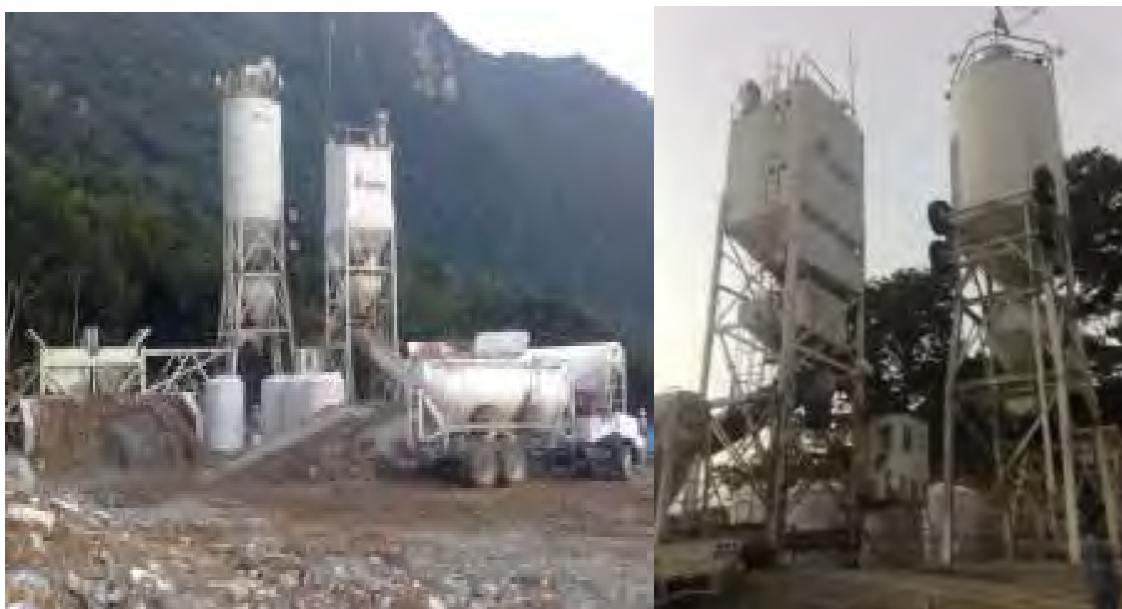
FIGURA 13 PLANTA CEMEX, LAS PILAS, PUE.
