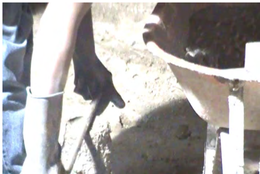
FIGURA 29 ENRASADO DE CONCRETO - RODAMIENTO DE VARILLA
