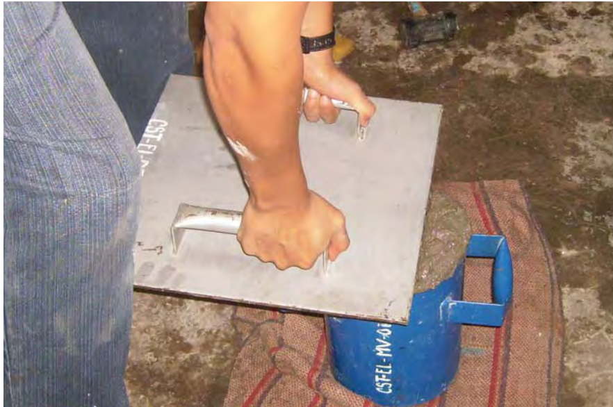
FIGURA 84 ENRASE CON PLACA METÁLICA - 1
