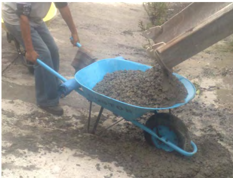
FIGURA 22 TOMA DE MUESTRA DE CONCRETO FRESCO
