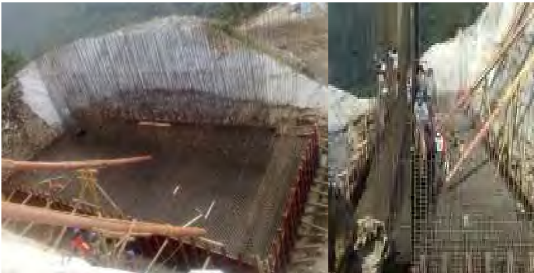
FIGURA 6 ZAPATA DEL ESTRIBO #1 DEL PUENTE “SAN MARCOS”
