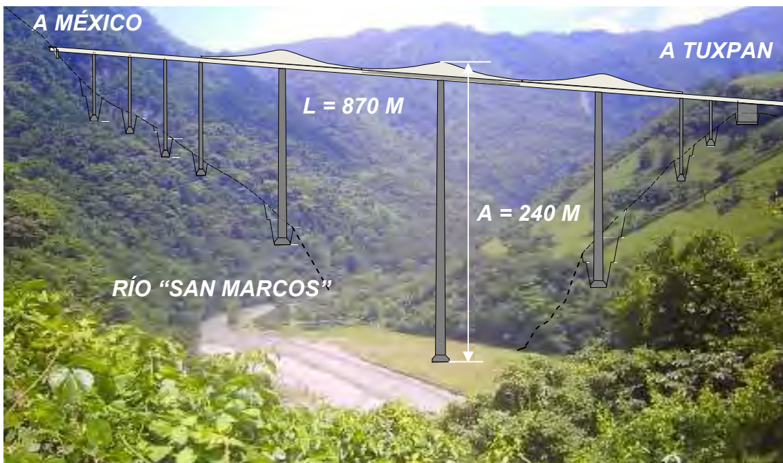
FIGURA 5 PUENTE “SAN MARCOS”
