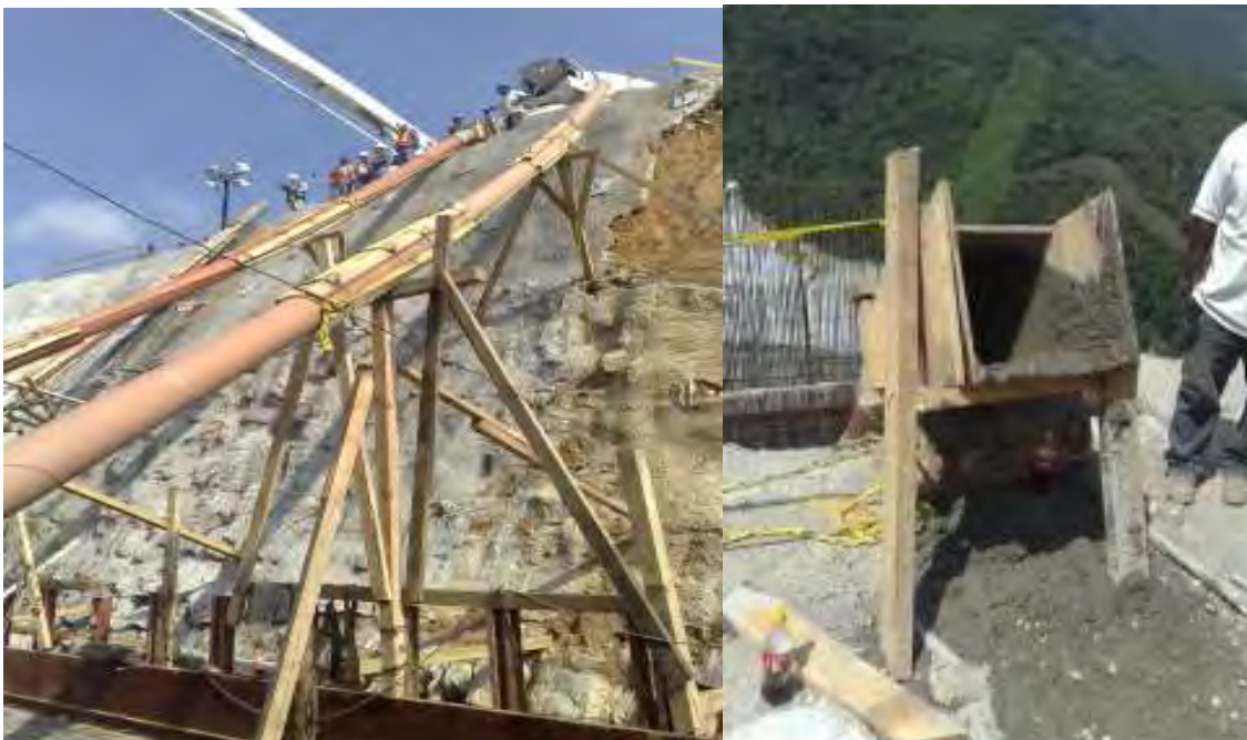
FIGURA 14 TUBERÍA DE PVC PARA VACIADO DE CONCRETO
