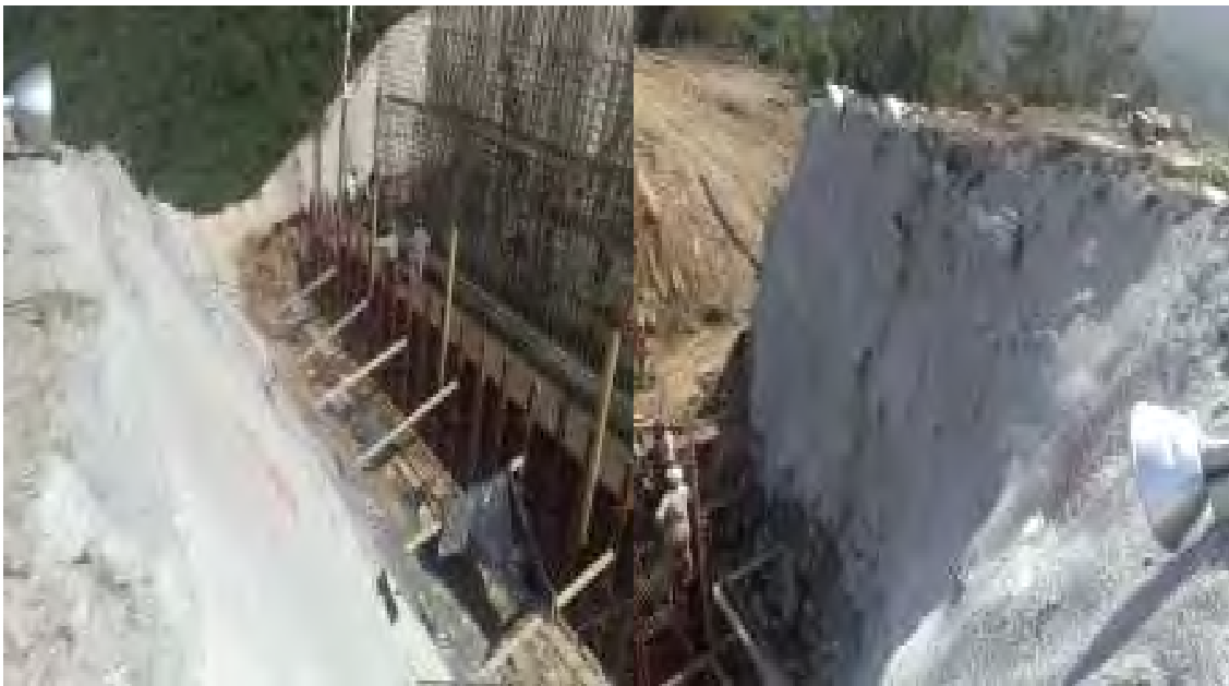
FIGURA 16 CONCRETO LANZADO EN TALUDES
