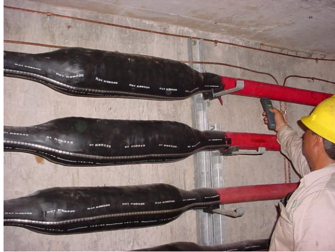
Foto 36. Lectura de temperatura de los empalmes
