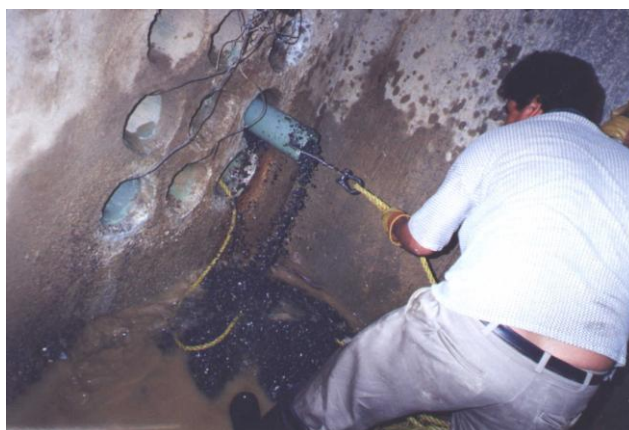
Foto 17. Limpieza de los ductos
