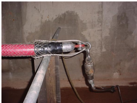
Foto 8. Durante el jalado del cable
