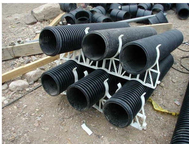
Foto 16. Separadores de los cables
