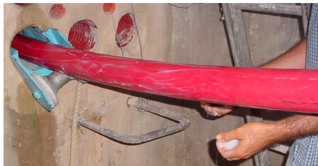
Foto 21. Lubricación del cable
