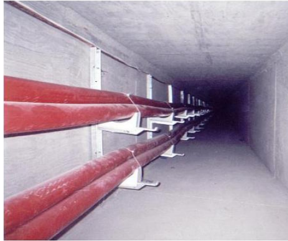
Foto 25. Montaje de cables en galerías
