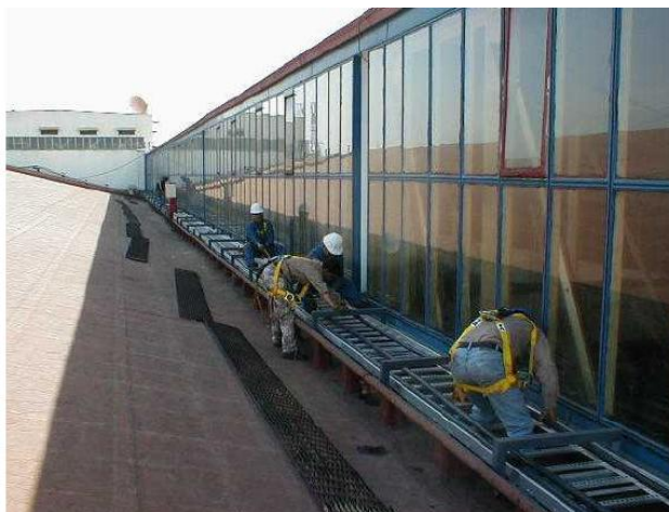
Foto 31. Tendido del cable con el método manual
