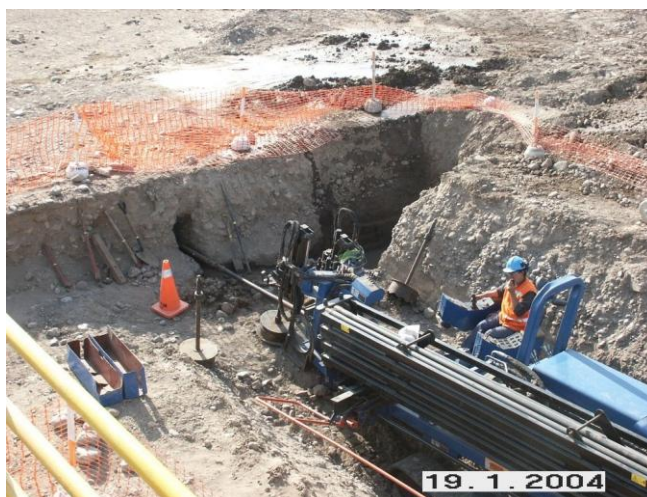
Foto 22. Barrenación direccional
