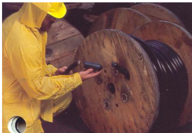
Foto 1. Verificación del sello de capuchones termocontráctiles
