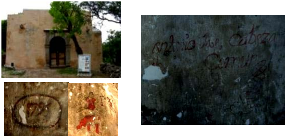
Imágenes 10 – 13. Capilla Segunda de Nájjar. Exterior; Fecha en muro del evangelio; ángel pasionario en muro de entrada; nombre en evangelio.
