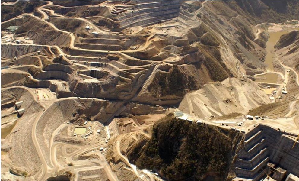
Figura 2.3. Estado de la construcción del P.H. La Yesca en Diciembre de 2009
