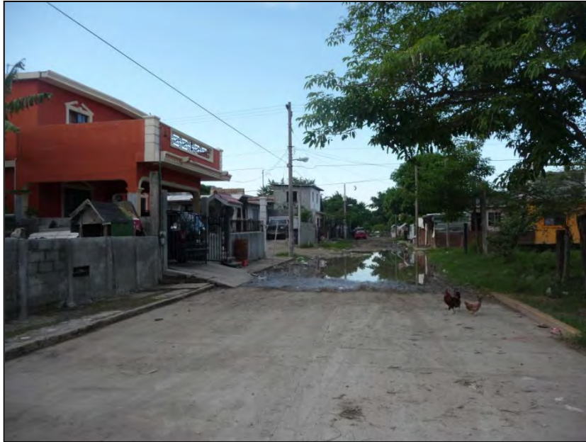
Imagen 27. Construcción de segundos niveles en las casas de la colonia a causa de las inundaciones. Fuente: Trabajo de campo realizado en 2009, fotografía de José Lambarri.
