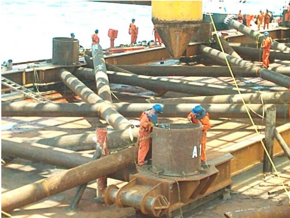
FOTOGRAFÍA 4.49 FUE NECESARIO REBAJAR EL BORDE SUPERIOR DE LOS CASQUILLOS DE ESQUINA, PARA PERMITIR EL ACOPLAMIENTO ADECUADO CON LAS COLUMNAS
