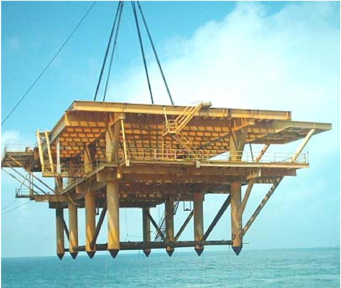
FOTOGRAFÍA 4.44 EL IZAJE DE LA SUPERESTRUCTURA SE REALIZÓ EN FORMA LENTA. TOMANDO COMO REFERENCIA EL HORIZONTE SE PUEDE APRECIAR LA POSICIÓN HORIZONTAL OBTENIDA.
