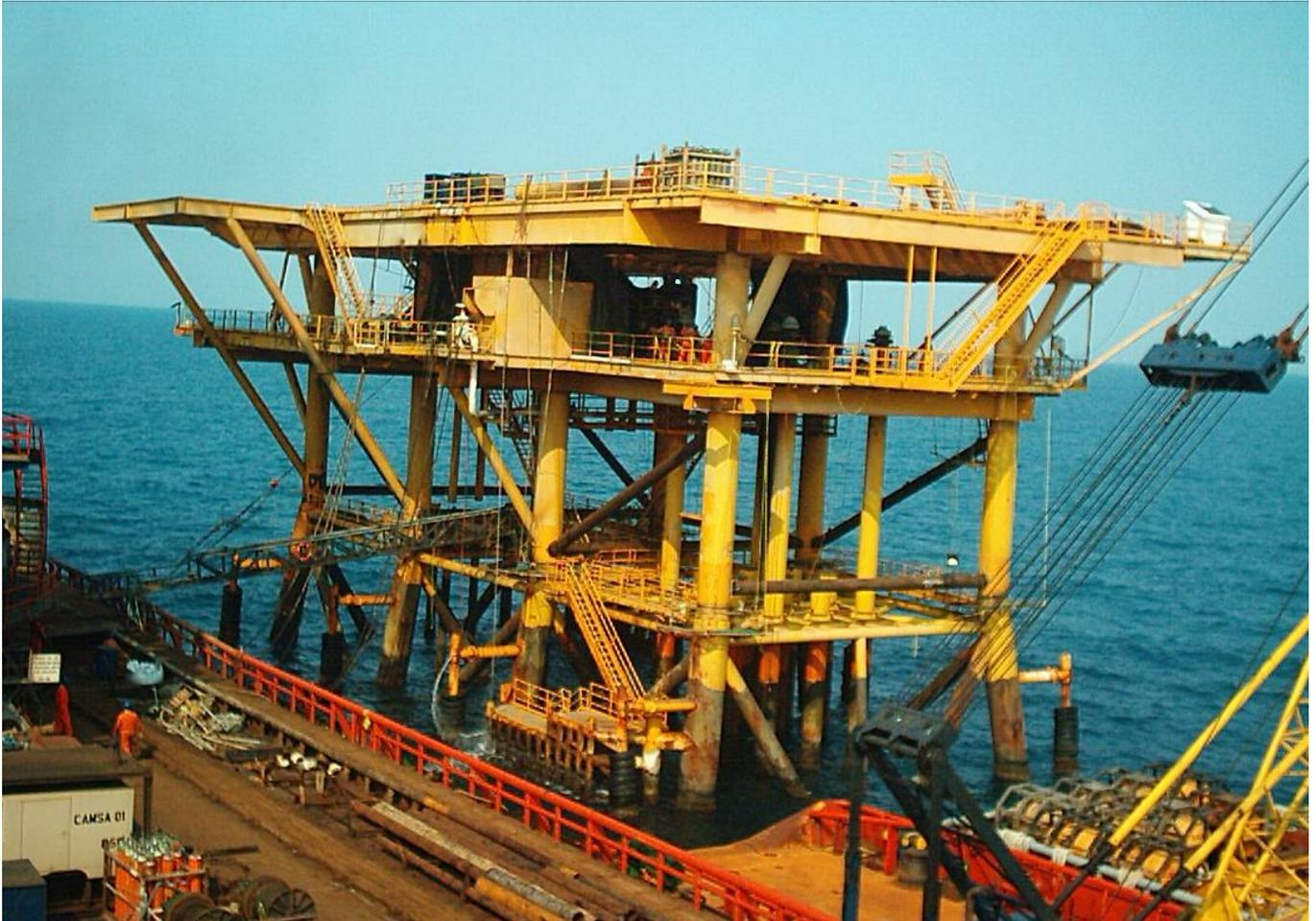
**PLATAFORMA DE PERFORACIÓN ABKATUN – I CON EL BARCO-GRÚA TOLTECA POSICIONADO A UN COSTADO, PARA REALIZAR LOS TRABAJOS DE RECUPERACION DE LA SUPERESTRUCTURA.**
