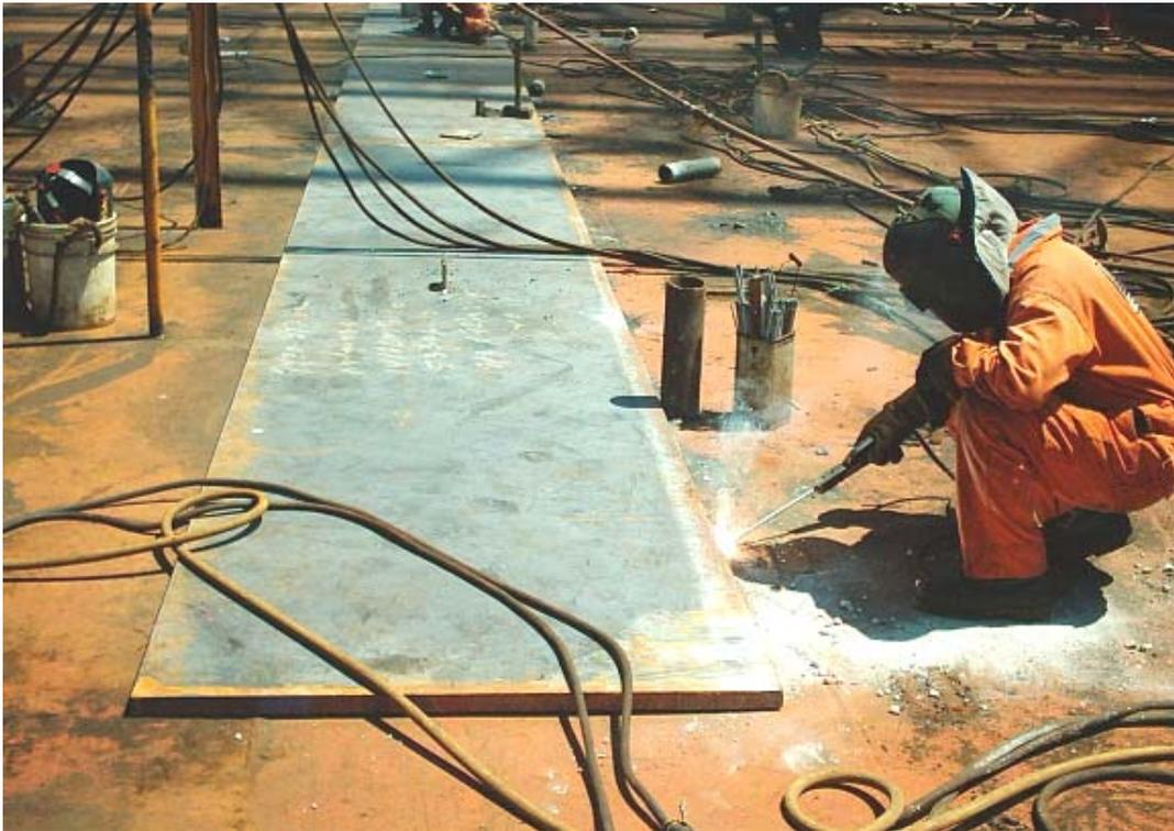
FOTOGRAFÍA 4.32 COLOCACIÓN DE PLACA DE DESLIZAMIENTO
