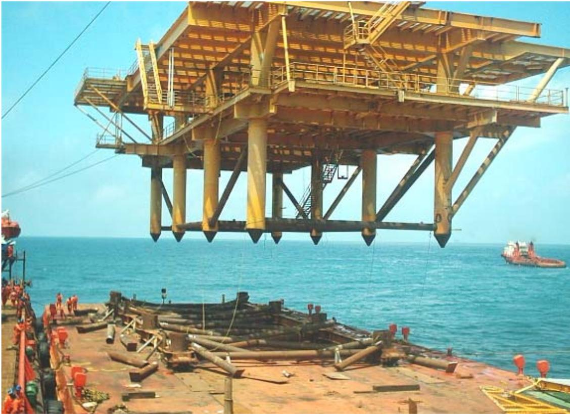
FOTOGRAFÍA 4.45 EL BARCO GRÚA SE POSICIONÓ ALEJADO DEL JACKET, Y EL CHALÁN CON EL MARCO DE APOYO Y ARRASTRE SE COLOCÓ BAJO LA SUPERESTRUCTURA IZADA
