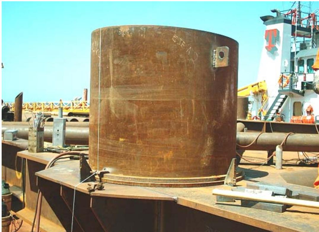
FOTOGRAFÍA 4.31 COLOCACIÓN Y ORIENTACIÓN DE CASQUILLOS PARA RECIBIR A LAS COLUMNAS DE LA SUPERESTRUCTURA
