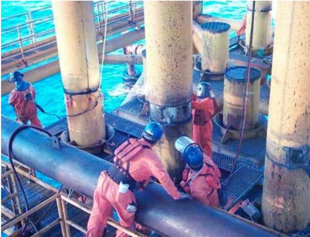
FOTOGRAFÍA 4.11 CAPA CEMENTANTE ENTRE LOS TUBOS DE 30" Y OTRO INTERNO DE 20" DE DIÁMETRO DEL POZO PRODUCTOR
