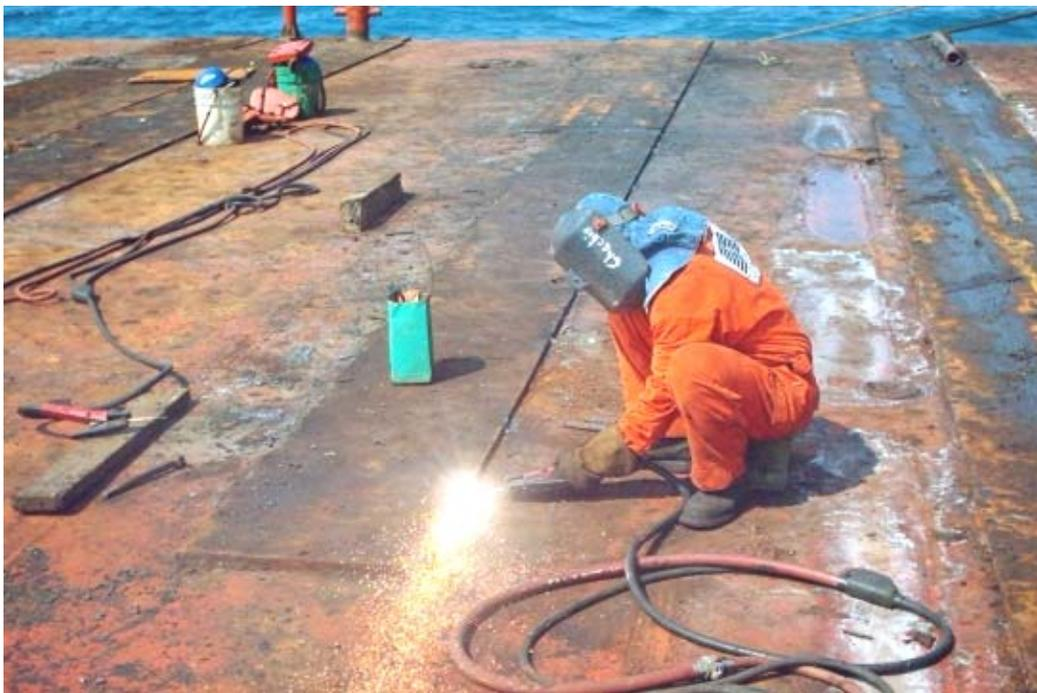
FOTOGRAFÍA 4.23 TRABAJOS DE PREPARACIÓN DE LA CUBIERTA DEL CHALÁN PARA EL ARMADO DEL MARCO
