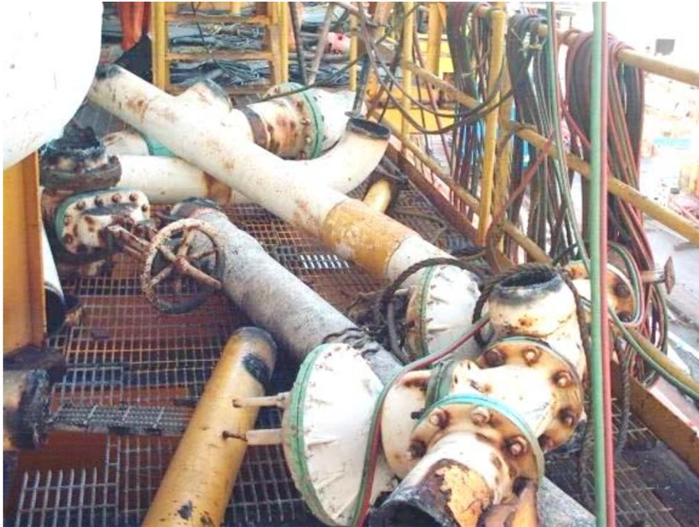
FOTOGRAFÍA 4.4 TUBERÍAS Y VÁLVULAS DESMANTELADAS ANTES DE SER TRASLADAS A LA CUBIERTA DEL B/G TOLTECA
