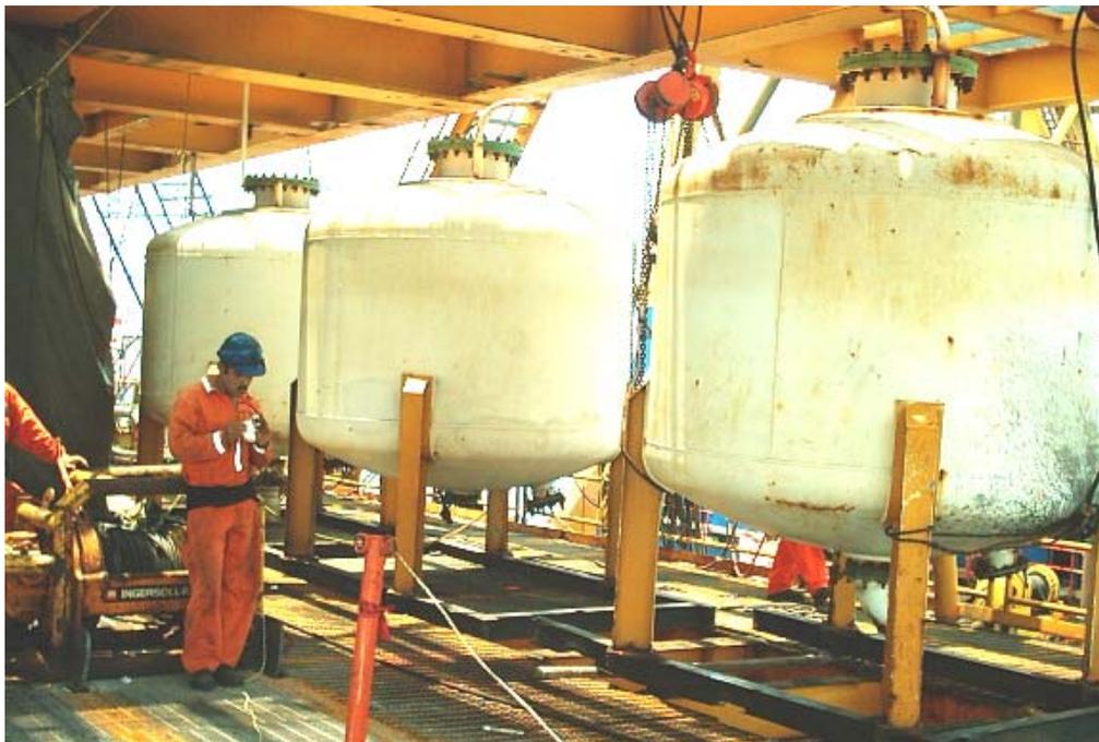
FOTOGRAFÍA 4.3 DESMONTAJE Y RETIRO DE EQUIPOS Y TANQUES
