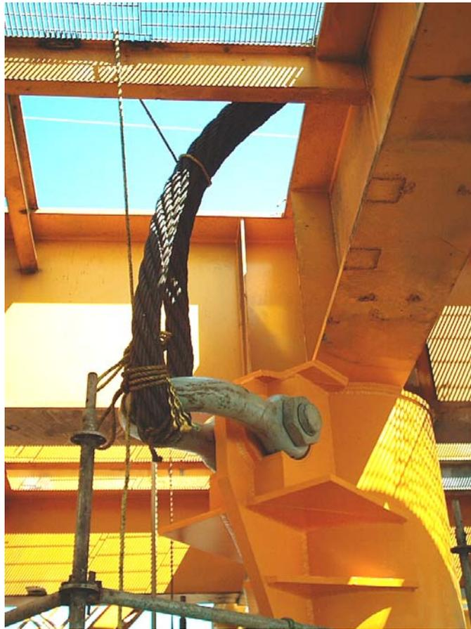
FOTOGRAFÍA 4.42 COLOCACIÓN DE LOS CABLES Y GRILLETES
