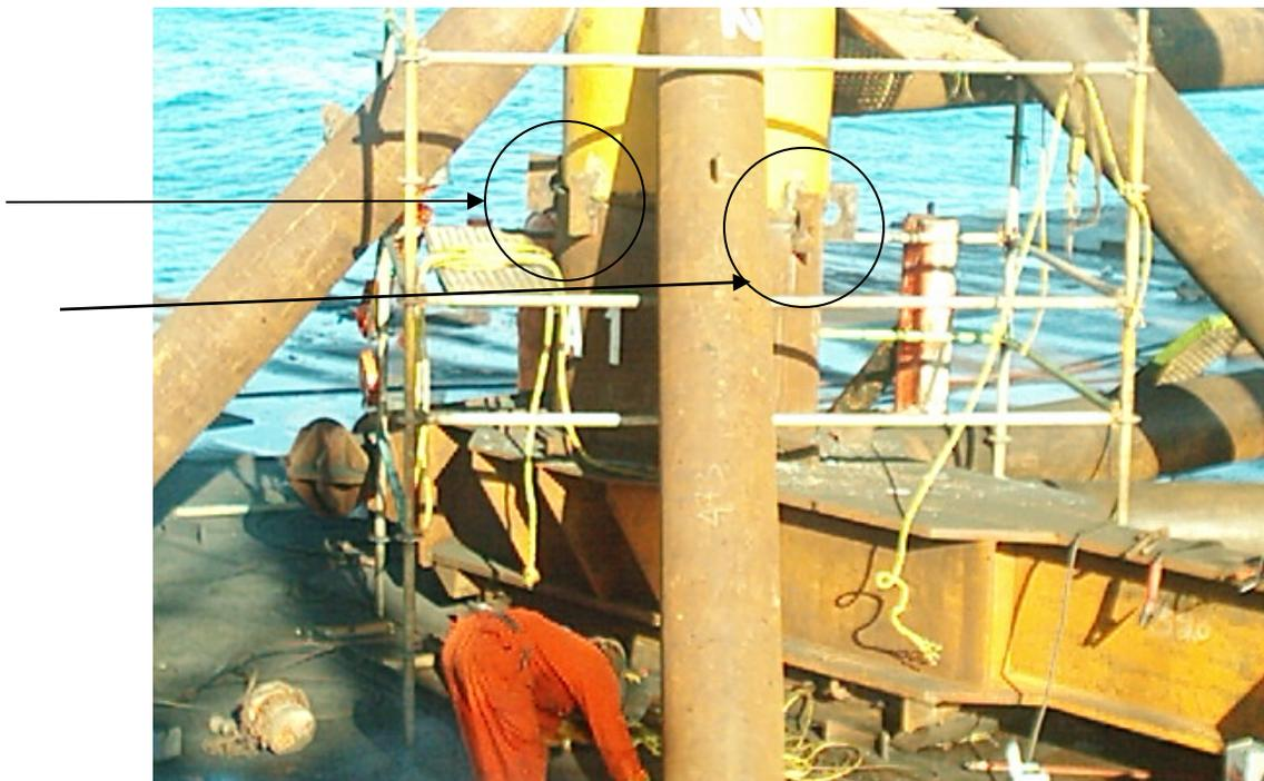
FOTOGRAFÍA 4.54 EN CADA CONEXION PIERNA-CASQUILLO SE COLOCARON OCHO "GRAPAS" DE UNION, DE PLACA DE 1/2" ESP.
