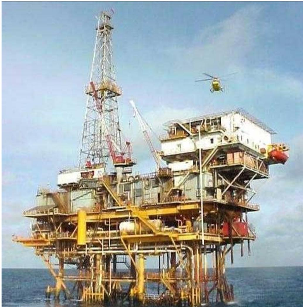
FIG 1.10 PLATAFORMA TÍPICA DE PERFORACIÓN EN LA SONDA DE CAMPECHE CONTENIENDO A LOS PAQUETES QUE CONFORMAN EL EQUIPO DE PERFORACIÓN Y DE TRATAMIENTO PRIMARIO, DEL CRUDO EXTRAÍDO.
