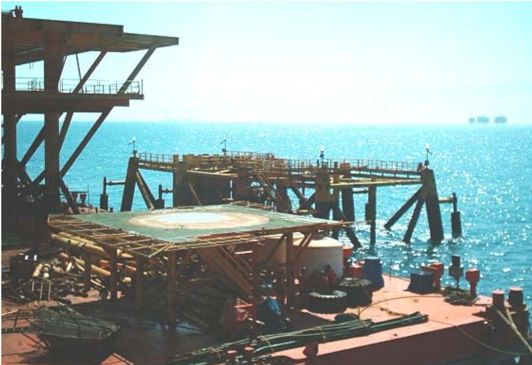
FOTOGRAFÍA 4.56 LOS PILOTES DE LA SUBESTRUCTURA FUERON TAPADOS CON PLACAS CIRCULARES Y EN LAS ESQUINAS SE COLOCARON LAS SEÑALIZACIONES LUMINOSAS DE ACUERDO A PROYECTO PARA DEJAR LA SUBESTRUCTURA ASEGURADA MIENTRAS PEP DECIDE SU FUTURA UTILIZACIÓN.
