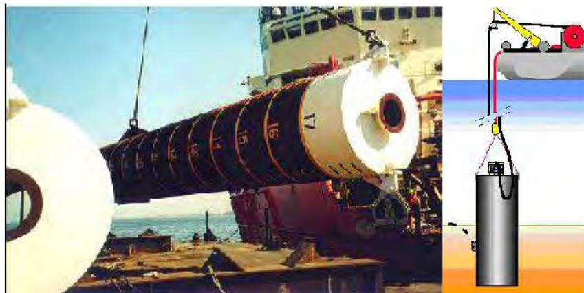
Figura 2.14 Pilotes hincados por succión
