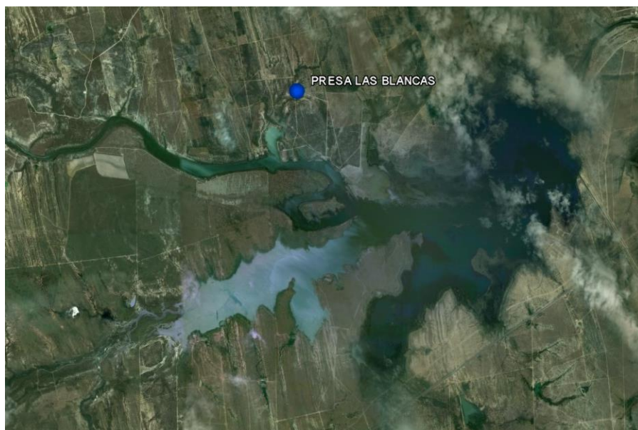
Figura 5.9 Presa Las Blancas
