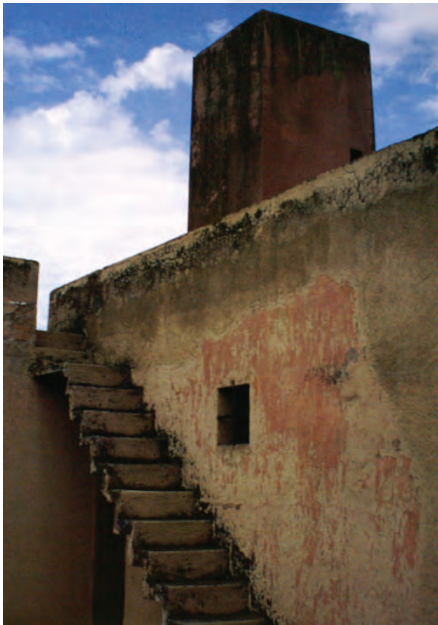
Foto: Detalle azotea 1 er Casa de Luis Barragán 36
