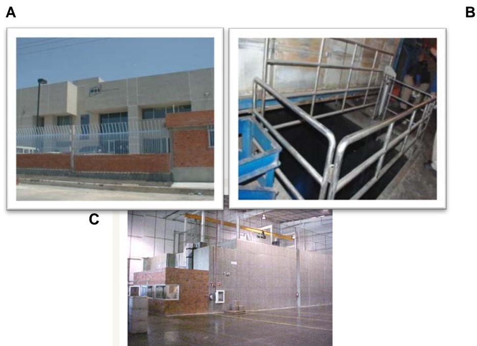
Figura 10. Planta de irradiación gamma ( \gamma ) 'Sterigenics', (A), piscina de almacenamiento de la fuente de irradiación (B) y pared de hormigón del irradiador (C).
