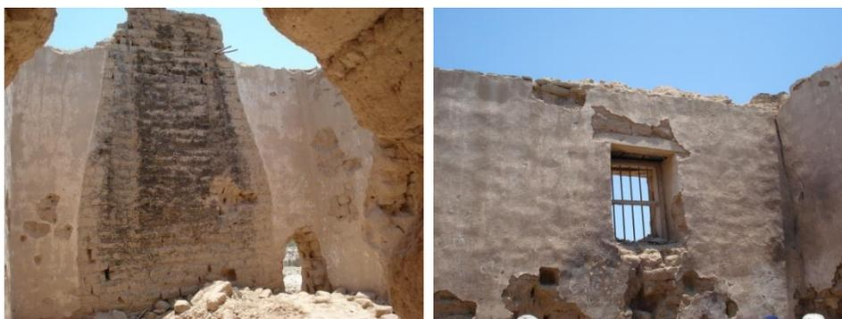
**Imagen 128.** Muros interiores con pérdida de aplanados y deterioro de muros.
