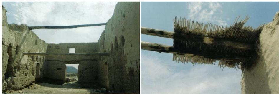
**Imagen 133.** Reintegración de cubiertas y restauración integral de las existentes.
