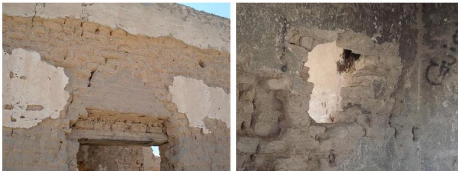
**Imagen 130.** Muros con presencia de grietas y pérdidas parciales.
