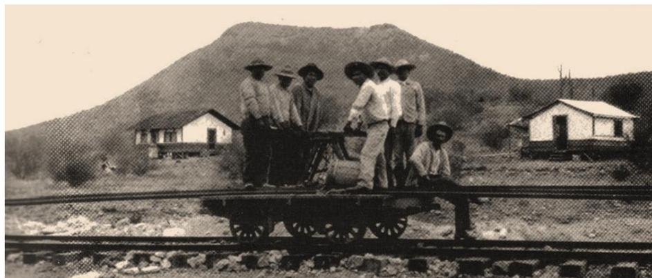
**Imagen 7.** Trabajos de colocación de vías en la línea ferroviaria del norte
