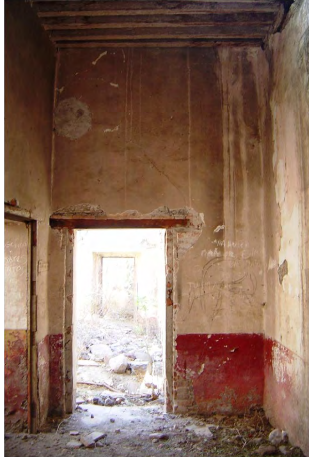
Interior de una habitación.
