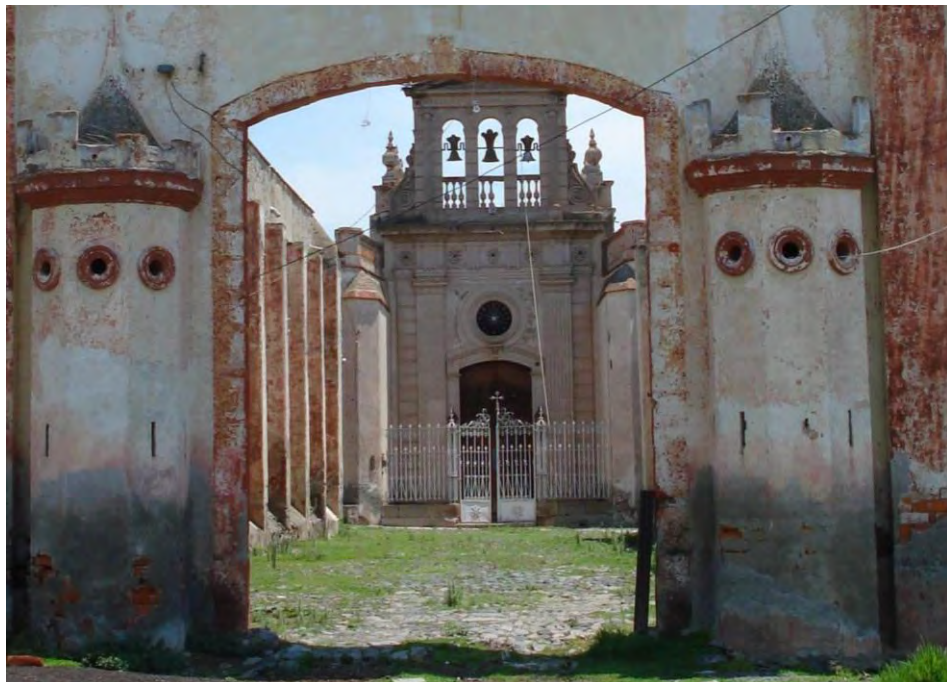
Eje de acceso a la capilla.
