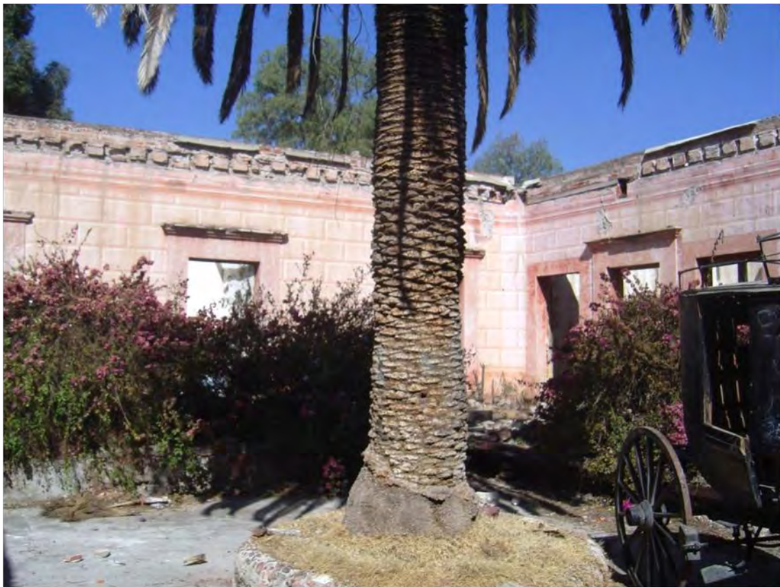
Panorámica del patio principal.
