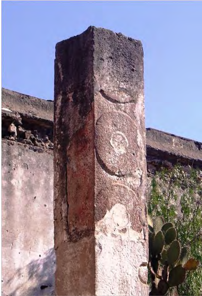
Detalle de columna de sillares de piedra.
