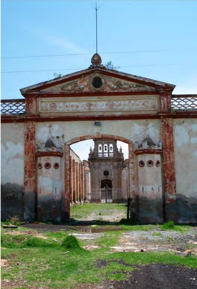
Acceso a la zona de trojes.
