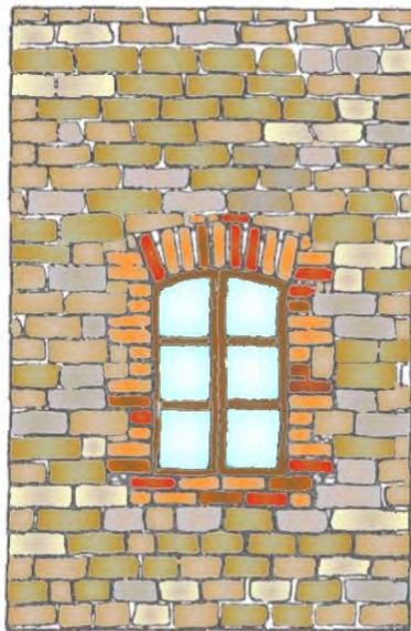
Cerramiento en arco en muro de sillares de adobe.
