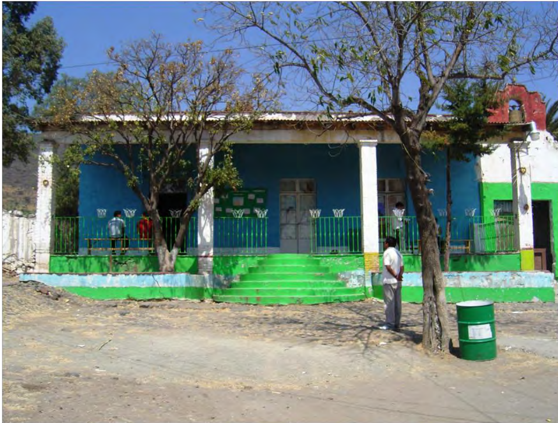
Detalle del pórtico.
