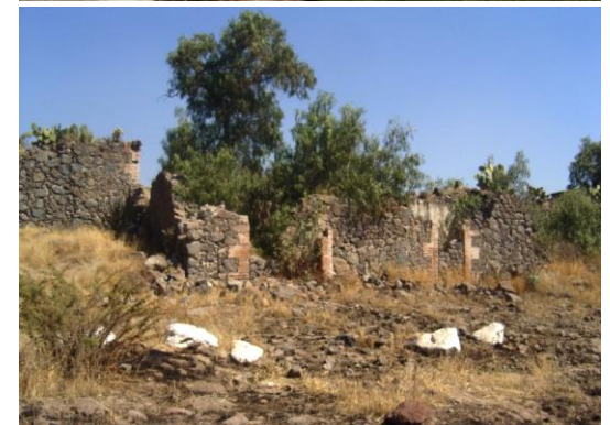
Las calpanerías solían ser junto con las bardas los elementos que delimitaban las haciendas; calpanerías de San Miguel Ometusco (arriba), San Bartolo Xala (centro), San José Cerro Gordo (abajo).
