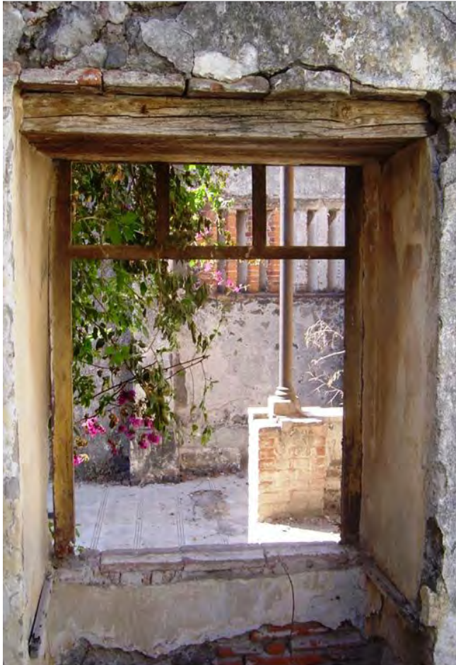
Detalle de una ventana.
