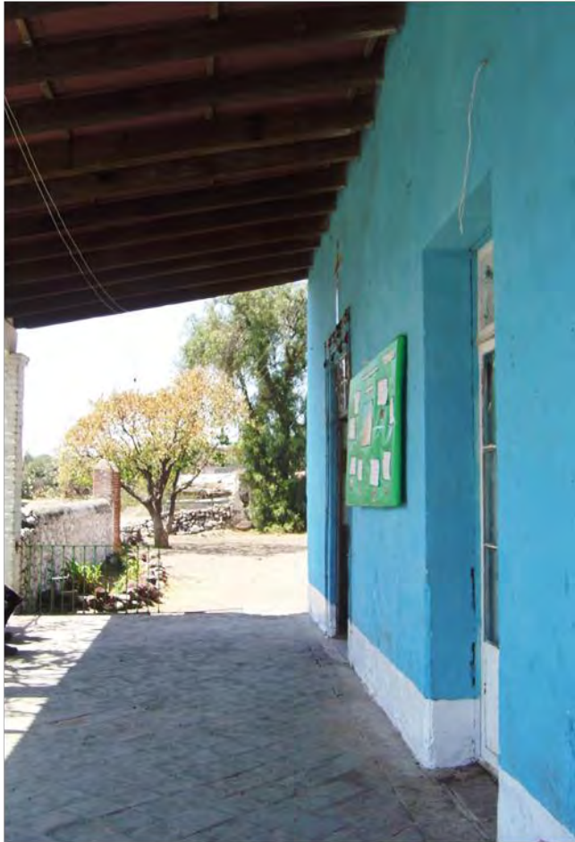
Vista del pórtico y acceso a la capilla.
