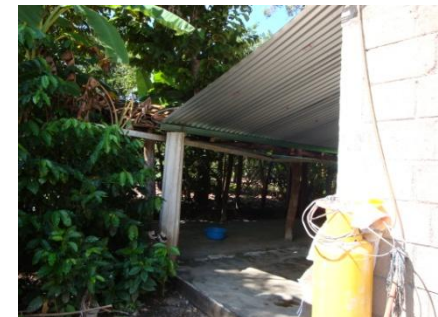
Ampliación de la vivienda realizada por sus ocupantes.
