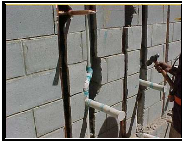
Fig. 2.35 Se deben evitar las perforaciones ya que reducen la resistencia de la mampostería
