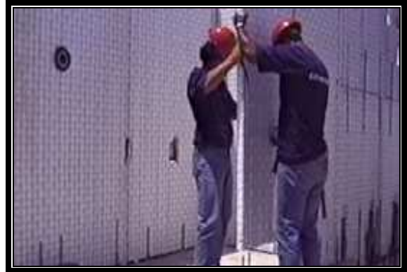
Fig. 2.5 Montaje de muros a la cimentación
