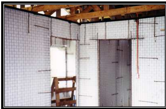
Figura 1.25 Ensamble de vigas y largueros sobre muros de panel estructural
