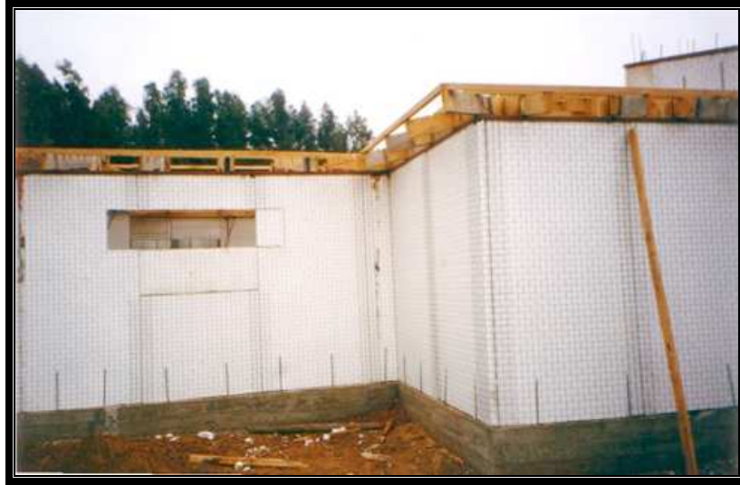
Fig. 2.4 Anclaje de muros y soportaría de la losa
