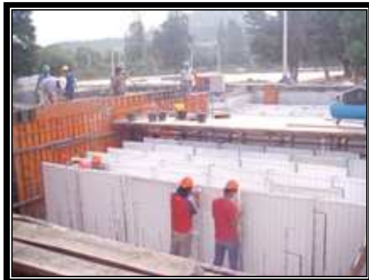
Figura 1.39 Utilización en plantas de tratamiento de agua
