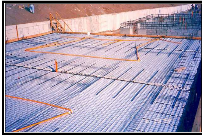
Figura 1.20 Colocación de acero en losa de entrepiso
