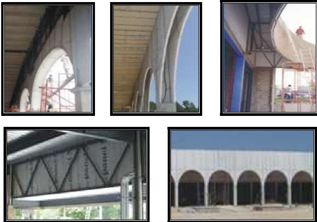
Figura 1.38 Aplicación del panel en pretils y fachadas principales
