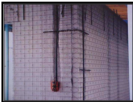
Figura 1.26 Detalle de colocación de instalación eléctrica
