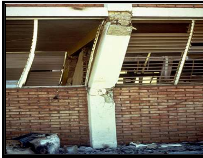
Fig. 2.37 Formación de columna corta por la colocación de un muro ligado a la columna
