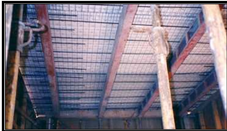
Figura 1.32 Elementos estructurales para el soporte de losa
