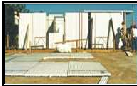
Figura 1.18 Corte y preensamblado de panel para losa
