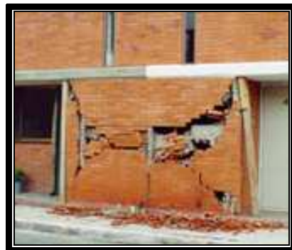
Fig. 2.31 Baja resistencia ante fuerzas sísmicas
