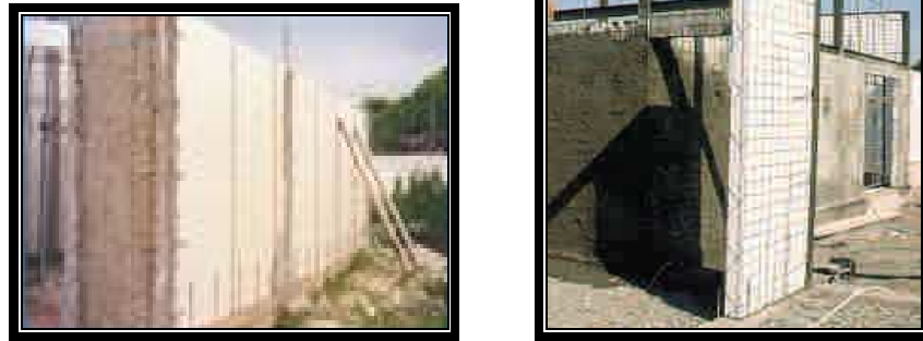
Figura 1.14 Anclaje del panel estructural a cimentación
