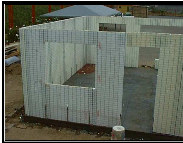
Figura 1.5 Panel estructural armado y ensamblado
