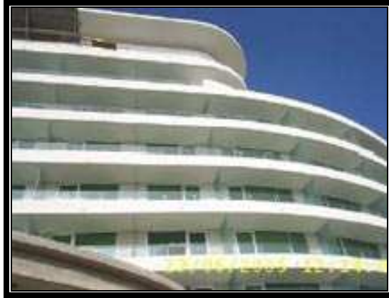
Fig. 2.2 Acabados finales de fachadas en edificación
