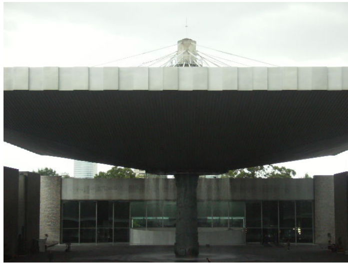
Figura 4.43: El paraguas y su caída de agua permanente.
