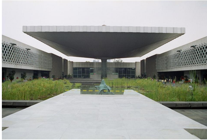
Figura 4.40: Vista patio interior.
