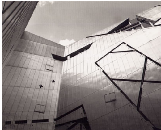
Figura 3.13: Líneas de las ventanas.
