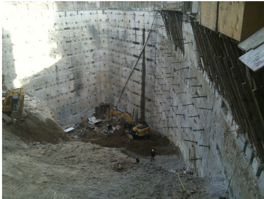
Vistas donde se aprecia el Muro Milán, colado en sitio.
