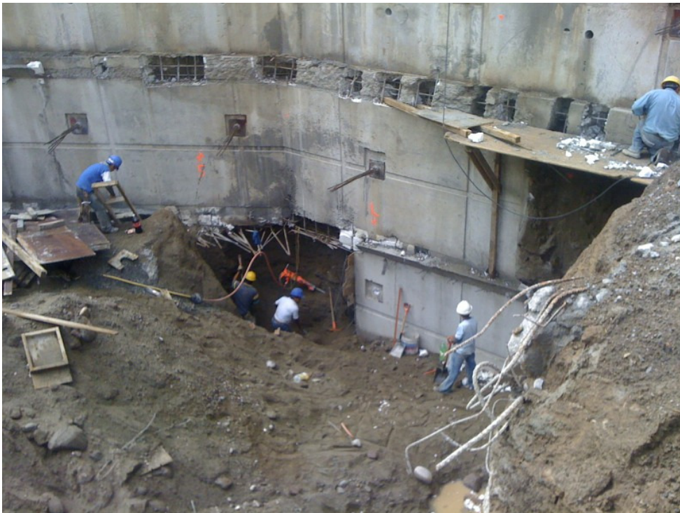
Construcción de Muro invertido en la sección sobre la calle de Insurgentes
