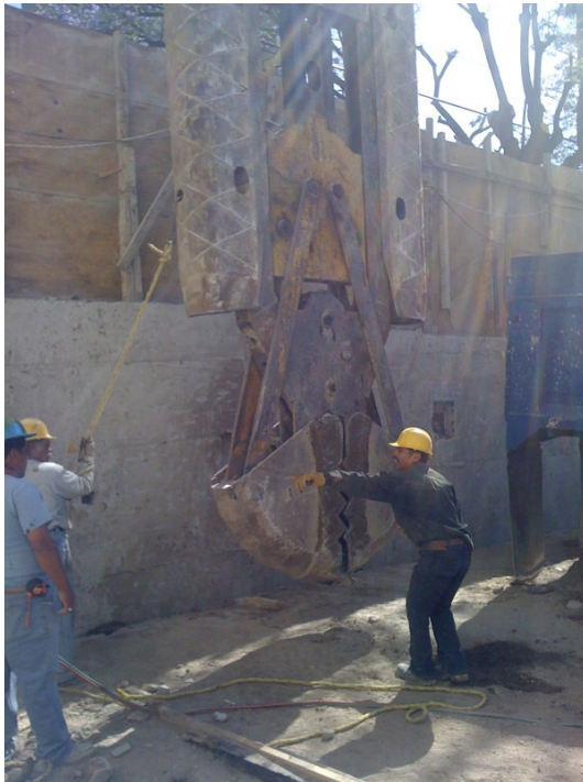
Perforación con la grúa almeja
