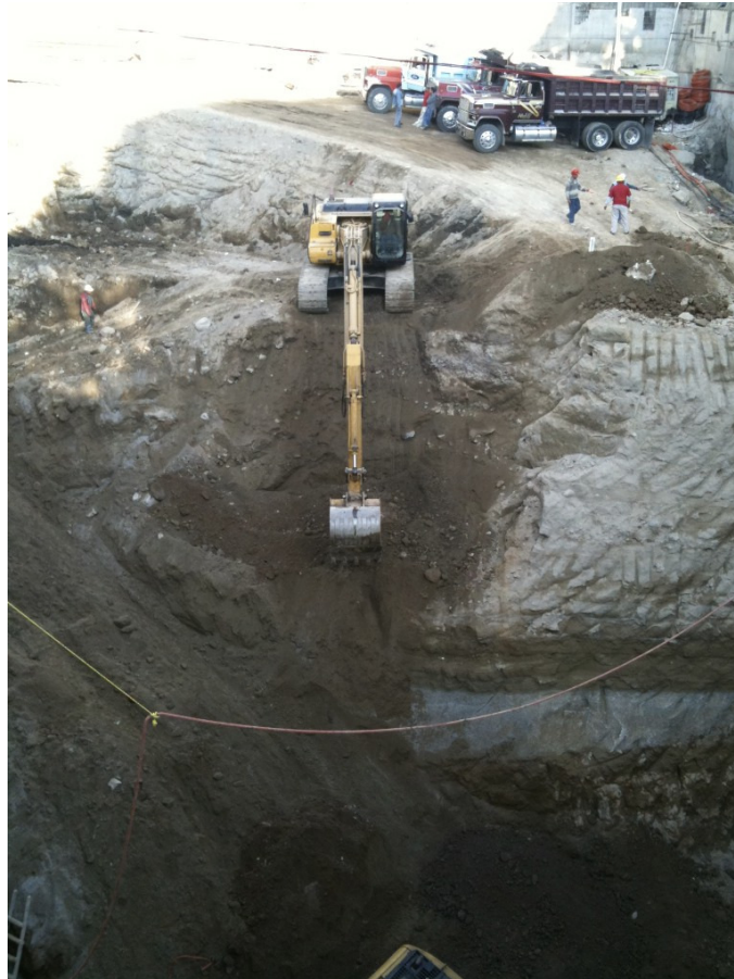
Movimiento de excavación tomada desde Av. Insurgentes
