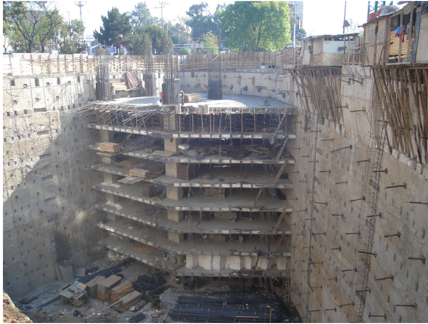
Vista poniente donde se aprecian las losas de los sótanos coladas
