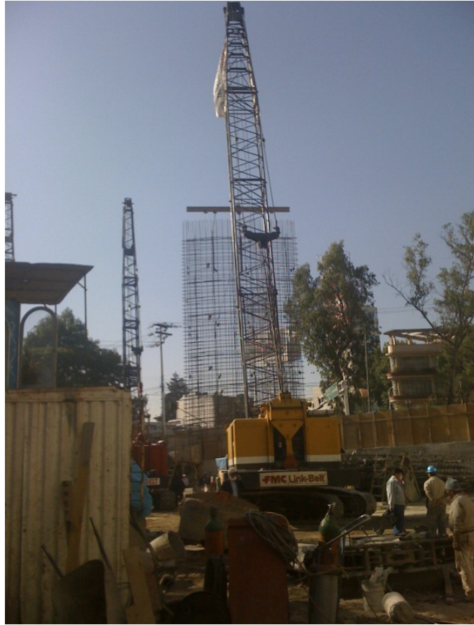
Colocación de Parrilla
