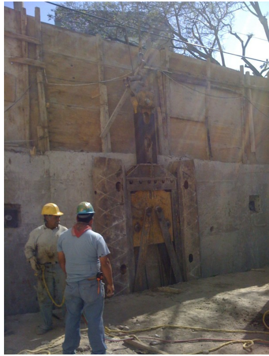
Perforación con la grúa almeja
