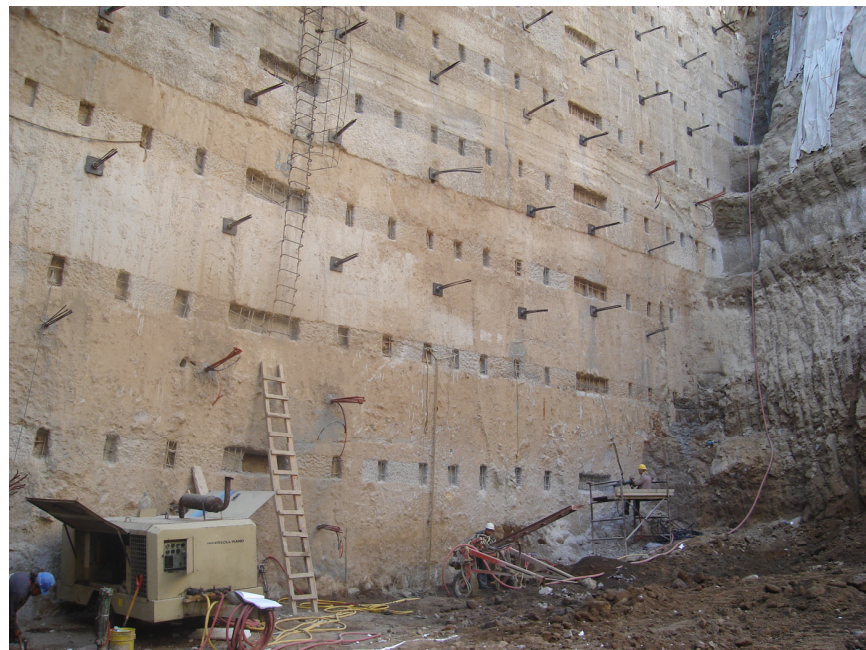
Vista del muro Milán desde el fondo de la excavación
