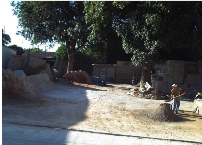
1.- PREPARANDO LA MEZCLA PARA ELABORAR EL BLOCK
