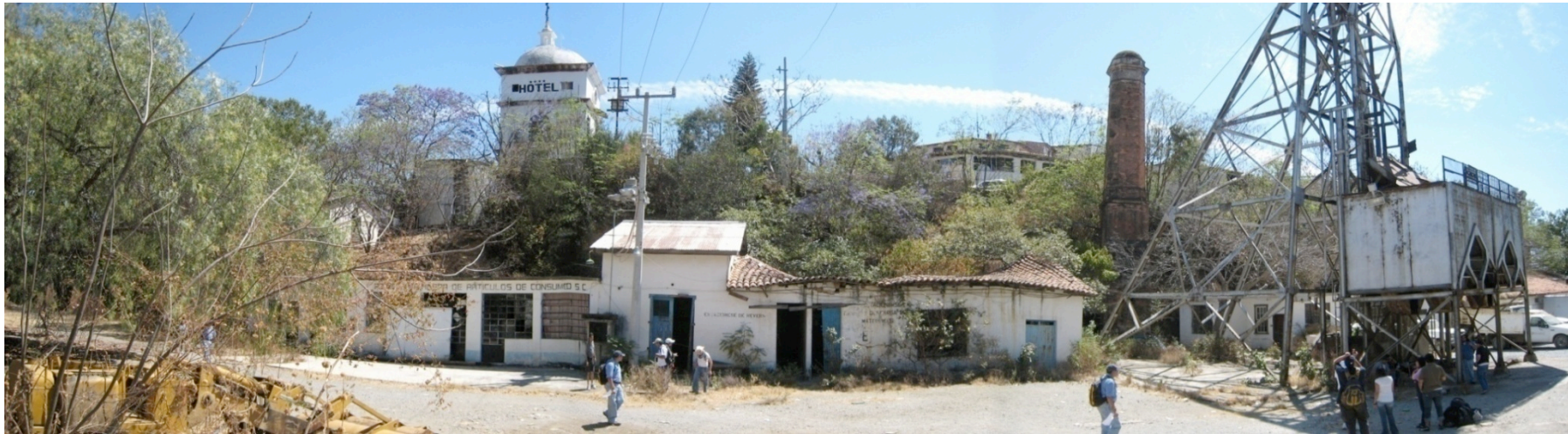
Vista panorámica (del lado izquierdo se aprecian construcciones existentes, del lado derecho se encuentra el tiro de la mina).
