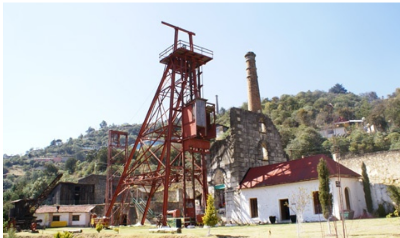
Vista del tiro de la mina
