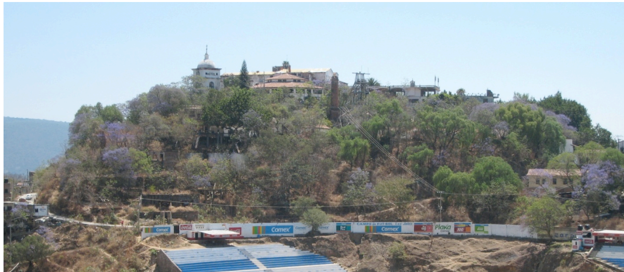
Vista panorámica del terreno.
