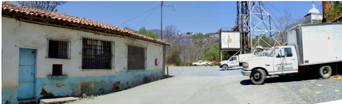
Vista del patio principal, se aprecia la torre que es el tiro de la mina.
