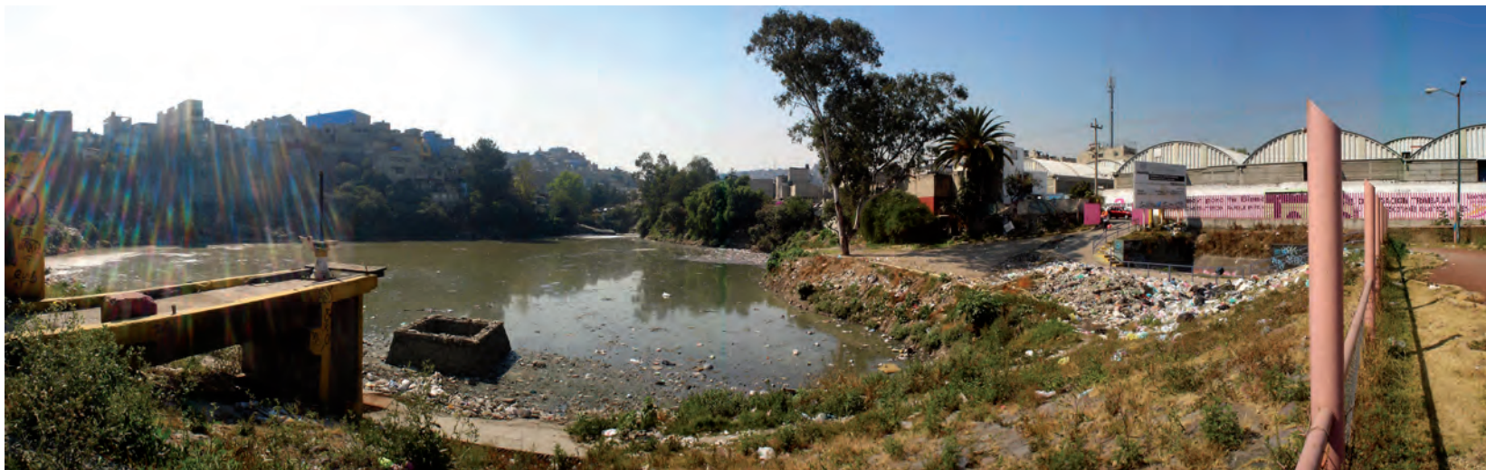
[vista de la presa A desde su parte oriente]
