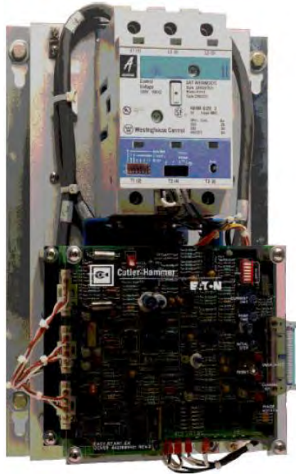
Figura 3.13 Arrancador de estado sólido.
