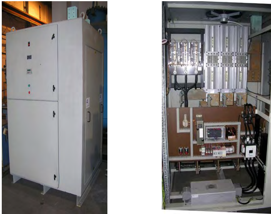
Figura 4.1 Rectificador trifásico controlado y sus componentes internos.
