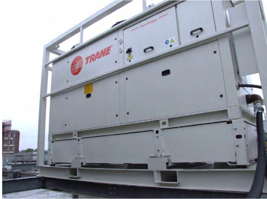
Figura 1.5 Enfriamiento de selladores por medio de chiller.
