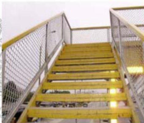
B.-PUENTE PEATONAL SUR
