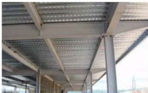
Sistema de Marcos de acero y losacero
