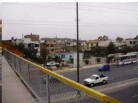
B.-PUENTE PEATONAL SUR
