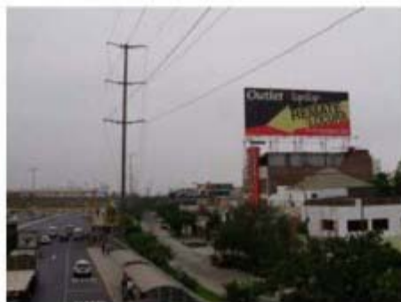
D.-TORRES DE ALTA TENSIÓN
