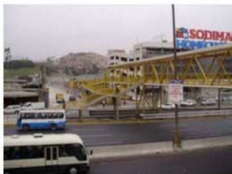
A.-PUENTE PEATONAL NORTE
