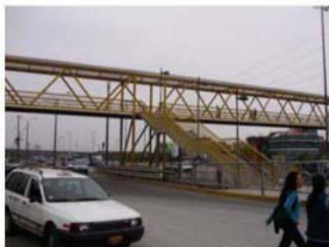
A.-PUENTE PEATONAL NORTE
