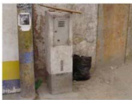
G.-MEDIDOR ELECTRICO
