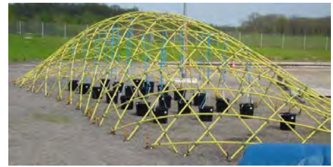
Vista exterior de una estructura semejante con este tipo de nodos
