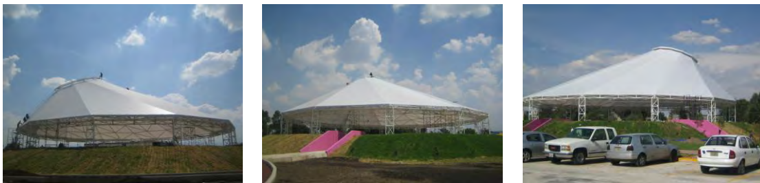
Terminación de la cubierta
