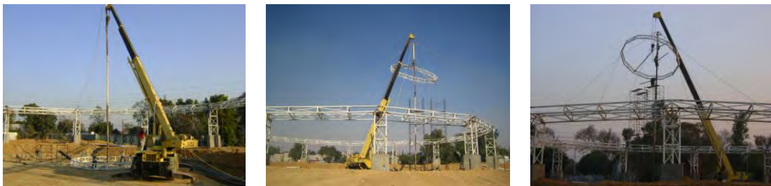
Colocación del anillo de compresión (corona)
