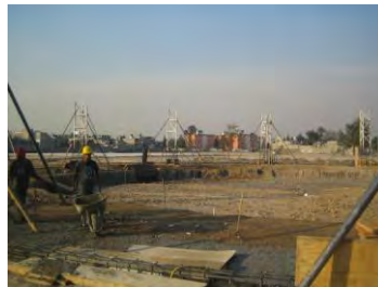
Nivelación y plomeo de las columnas antes del colado
