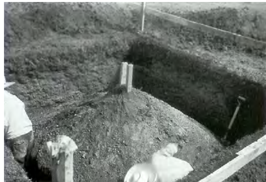
Procedimiento para la construcción del paraguas invertido
