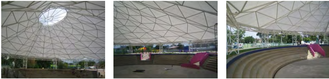
Ajustes sobre la colocación de la membrana
