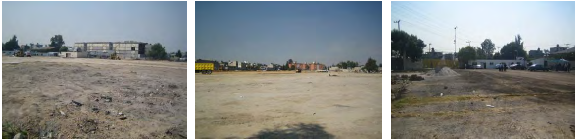
Trabajos de rehabilitación
