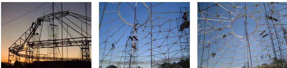
Colocación de las diagonales
