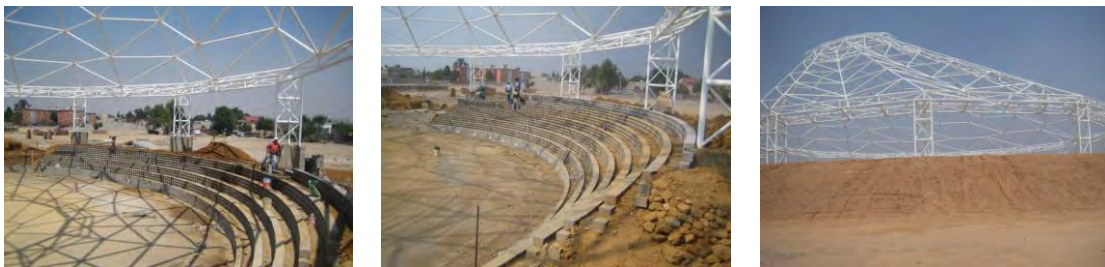
Construcción de las gradas y taludes
