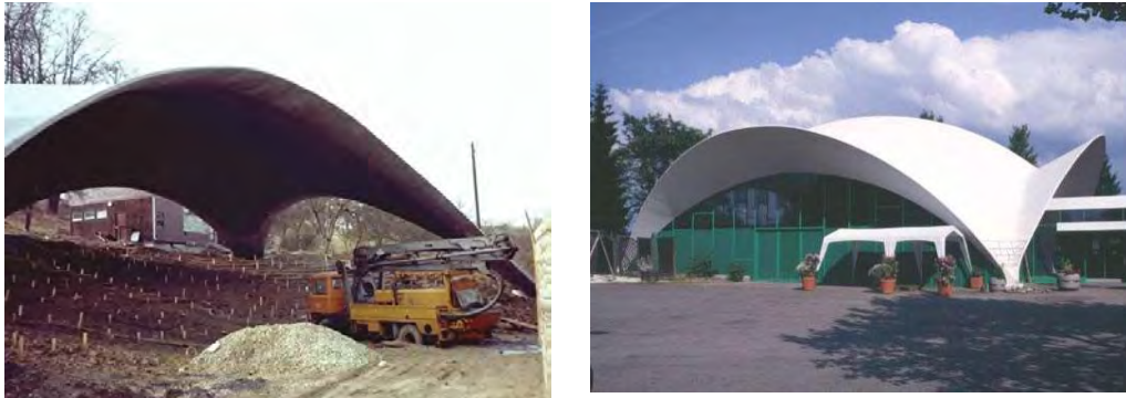
Imágenes de dos cascarones realizados por Isler sobre el concepto de la tela colgada 25
