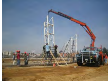
Colocación de las columnas sobre los armados de los dados
