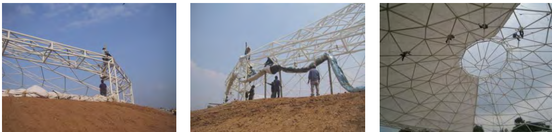
Colocación de la membrana sobre la estructura
