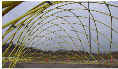
Vista interior de la estructura 44
