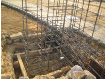
Colocación de las columnas sobre los armados de los dados
