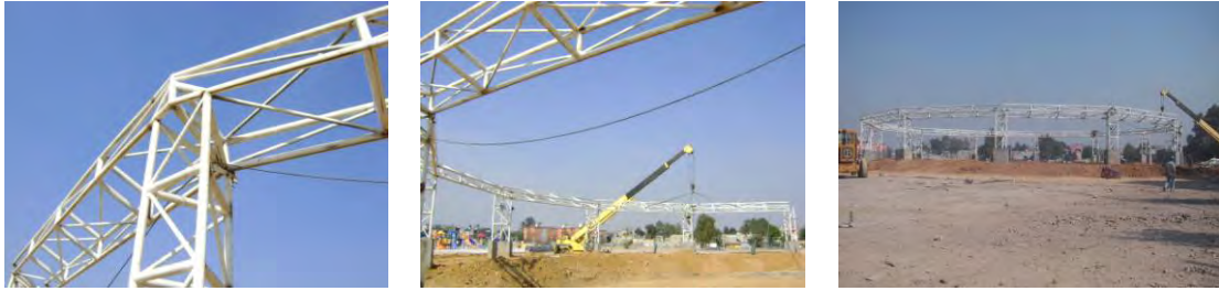
Terminación de montaje de la trabe perimetral
