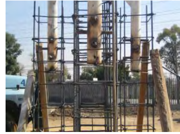
Colocación de las columnas sobre los armados de los dados
