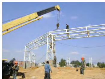
Inicio de montaje de la trabe perimetral
