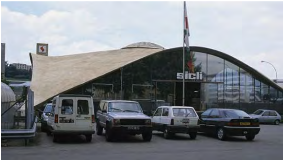
Edificio de oficinas de la compañía Sicli en Génova, Suiza 1969- 1970 29
