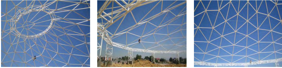
Retiro de los puntales y pintura de la estructura
