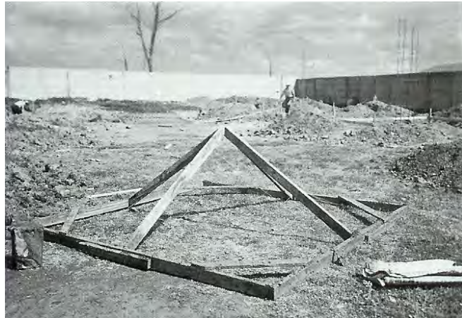
Procedimiento para la construcción del paraguas invertido
