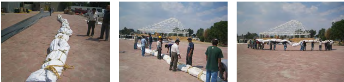
Transportación de la membrana a la obra
