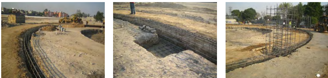
Inicio de los trabajos para cimentación
