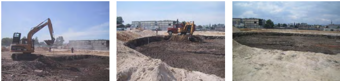
Imágenes del proceso de excavación y configuración del área para el teatro al aire libre
