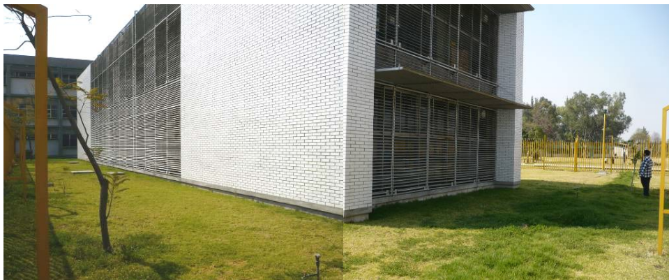
Fig. 5.4 Vista posterior del Centro de Cómputo.
