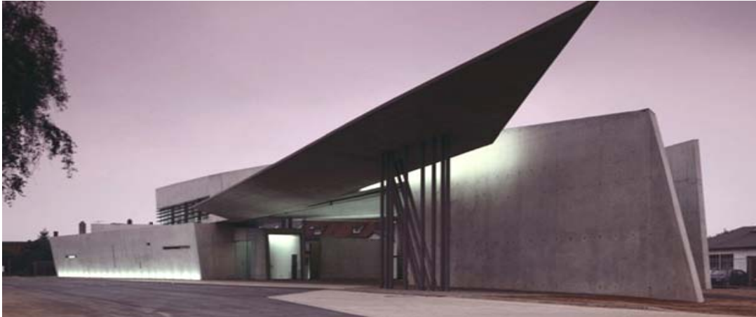
Fallida estación de bomberos de Zaha Hadid. Tomada: http://www.elpais.com/recorte
