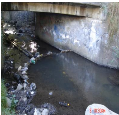
AN5. 1° dinamo. Antes de la nueva planta potabilizadora
