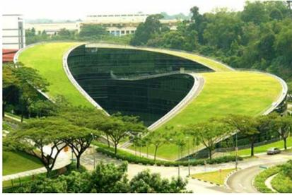
EL USO CUBIERTAS VERDES TRANSITABLES MANTIENE LA TEMPERATURA CONFORTABLE AL INTERIOR DE LOS EDIFICIOS, LO QUE SUPONE AHORRO EN ENERGIA ELECTRICA Y AIRE ACONDICIONADO.
