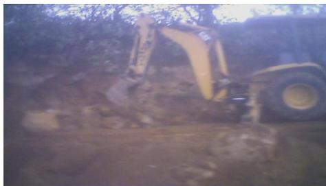
Figura 16. Retroexcavadora emparejando el terreno
