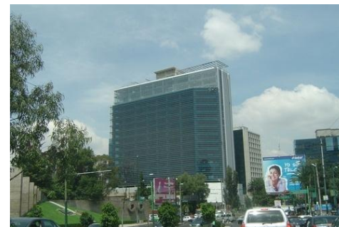
Ilustración 8.10. Vista de Avenida de los Insurgentes tramo sur.
