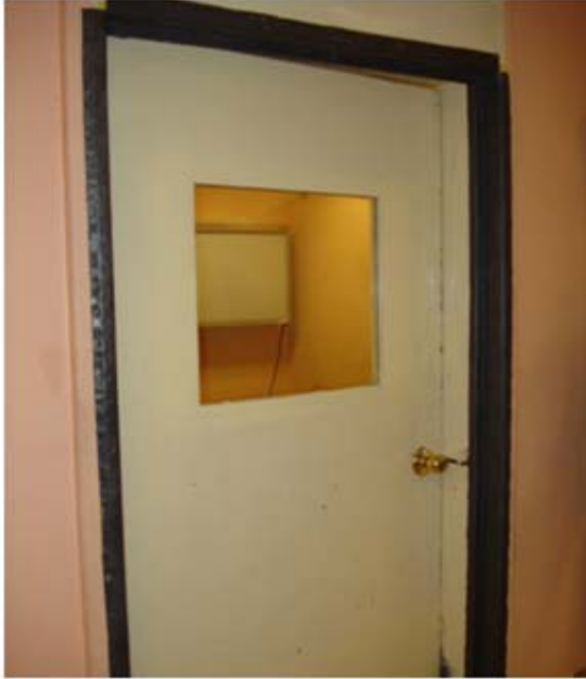
FIG- 23 SE USARAN ANGULOS O TIRAS DE PLOMO ADOADOS AL INTERIOR DE LAS JUNTAS O REMATES DE LOS MUROS Y PUERTAS
