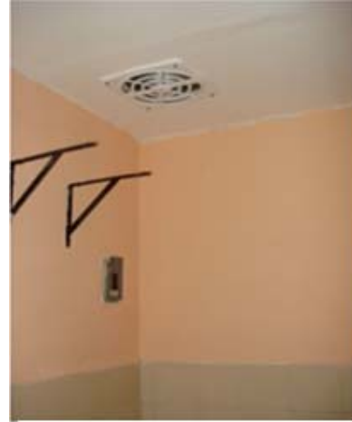
FOTO-3 Inyección de aire en el cuarto oscuro
