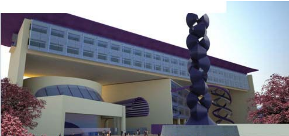
FIG- 13 Instituto Nacional de Medicina Genómica, fachada principal
