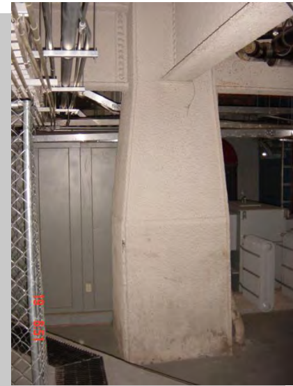
Detalle de reducción de columnas
