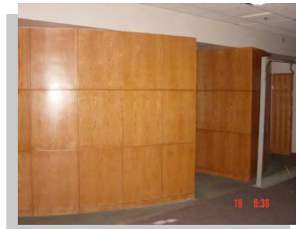
Muros forrados de madera
