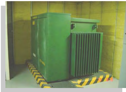
Muros aislantes de ruido
