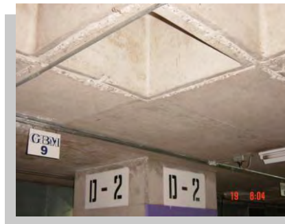
Losa de sótano
