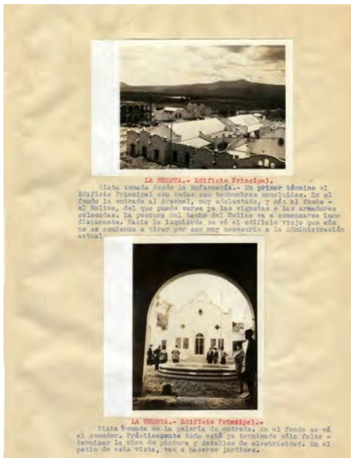
Fig. 6.2 Álbum del registro constructivo “Escuela Central Agrícola La Huerta”. aL Fondo se observa la Hacienda que será demolida para construir un nuevo edificio dentro del nuevo conjunto escolar. 1926. APECyFT. Fototeca.
