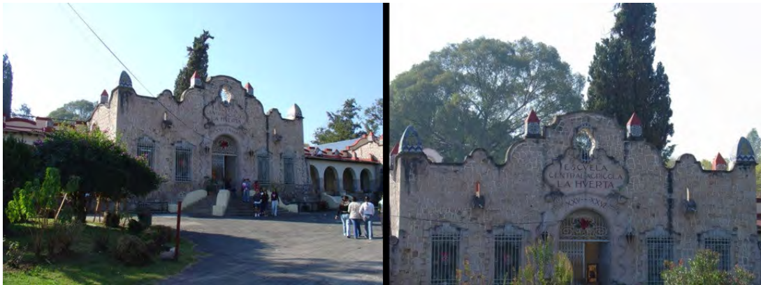
Fig. 14 Fachada de la Escuela Central Agrícola "La Huerta", estado actual del edificio.
