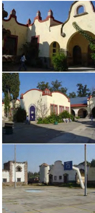
Fig. 15 Vista del patio interior, de la sala de higiene, canchas y silos de la Escuela Central Agrícola "La Huerta". Estado actual del edificio.
