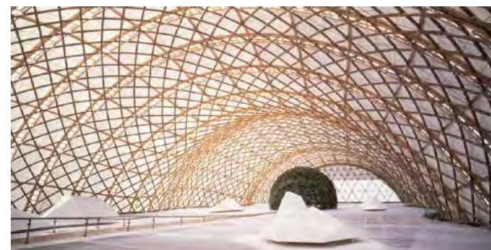
PABELLÓN DE JAPÓN, Expo 2000 Hannover - Alemania, 2000 . Estructura de tubos de cartón y lona de tela
