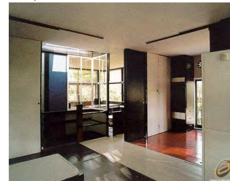
Dos vistas del interior de la Casa Schröder , donde se muestran los muros deslizantes que separaban los espacios para crear diversos escenarios. Estos muros funcionaban como persianas deslizantes que podían moverse de una manera fácil en la creación de diversos escenarios. Imágenes obtenidas de www.arquinauta.com/foros/Consultas-f10/casa-s...
