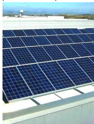
Paneles Fotovoltaicos de sílice policristalino de última generación. Imágenes obtenidas de www.kyocera.com
