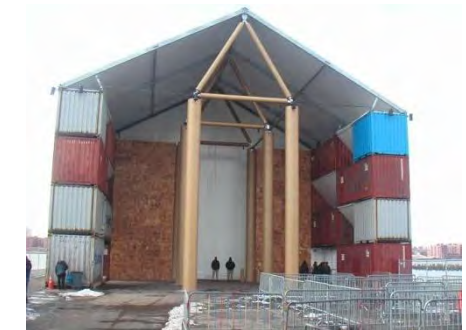
Estructura original del Museo Nómada de 2001. Estructura hecha de tubos de cartón unidos con nodos metálicos. Imágenes obtenidas de www.nyc-architecture.com/ARCH/ARCH-Shigero.htm
