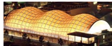
Pabellón Vasarely en Aix-en-Provence , en Francia de 2006. Estructura hecha de cartón, bambú y madera y lona. Imágenes obtenidas de www.designboom.com/eng/interview/shigeru_ban.html
