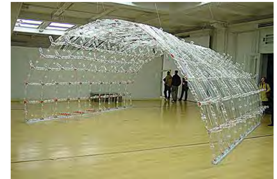
Estructura experimental de botellas de plástico y acrílico de 2005. Imagen obtenida de http://www.universes-in-universe.de/car/shanghai/2002/tour/s-tour-16.htm
