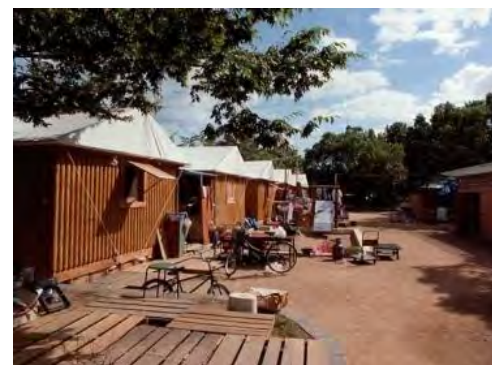
DOCUMENTO DE REGISTRO DE VIVIENDAS - Kobe, Japón, 1994 / Kaynasli, Turquía, 2000 / Bhuj, India, 2001 . Casas-Refugios hechos de tubos de cartón, maderas y lonas de plástico y telas
