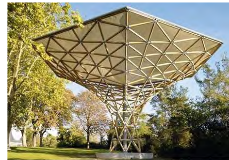
Pabellón Vasarely en Aix-en-Provence , en Francia de 2006. Estructura hecha de cartón, bambú y madera y lona. Imágenes obtenidas de www.designboom.com/eng/interview/shigeru_ban.html
