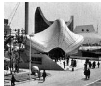
Antena de Radar cubierta por una estructura Neumática. Teatro Flotante Expo'70 Fue hasta la EXPO'70 en Osaka, Japón donde las estructuras neumáticas llegaron fueron uno de los actores principales de dicha exposición. Imágenes obtenidas de la Tesis de Maestría en Arquitectura Las estructuras neumáticas como estructuras superligeras de Julio Alberto Torres Serrano de 2005, p 23
