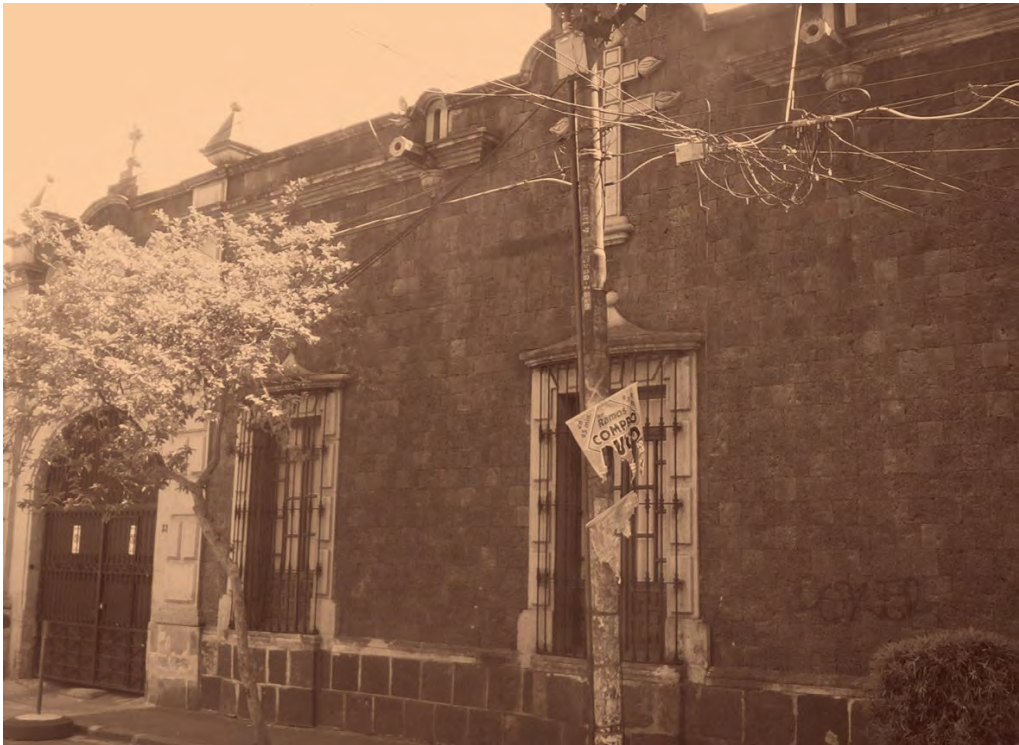
Casa de la Campana, misma que le da nombre a la calle donde se encuentra (acervo particular)
