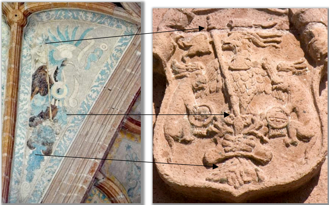
Figura 52. Plemento del Presbiterio y blasón en la fachada, ambos en el Norte. Fotos del autor.
