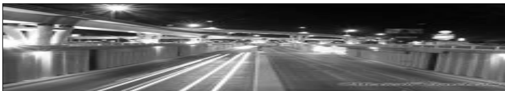
Puente automovilístico de cuatro pisos en Av. López Mateos, Mexicali, B.C.
