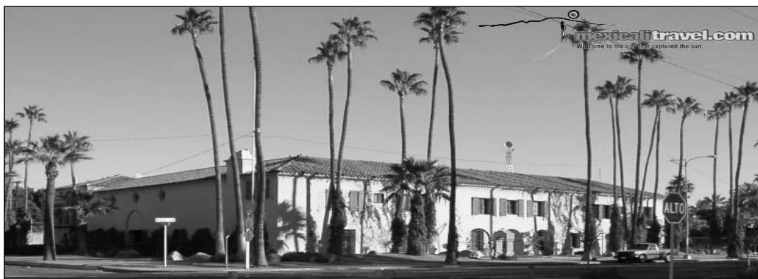
Edificio de la Compañía Colorado River, Mexicali, B. C.
