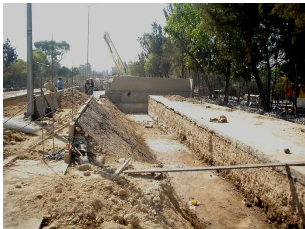
Corte del terreno para muro diagonal
