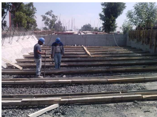
Cimbra para Tensores
