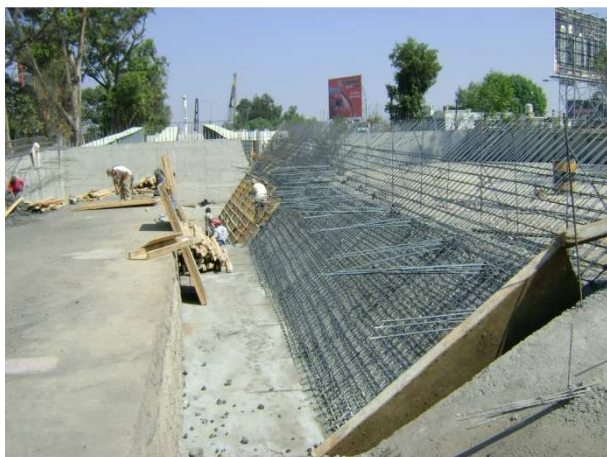
Armado estructural del muro de contención
