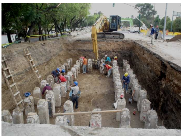
Nivelación del fondo y afine del terreno
