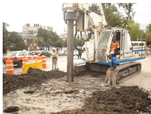
Foto. Equipo de perforación
