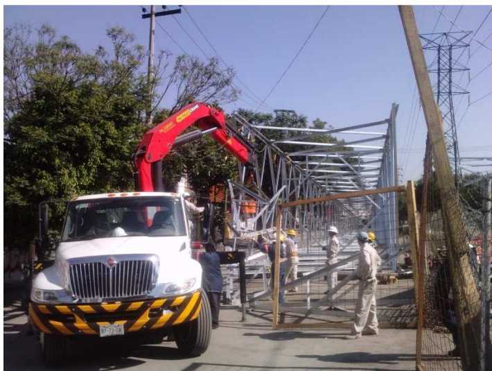
Foto .Apoyo con grúa
