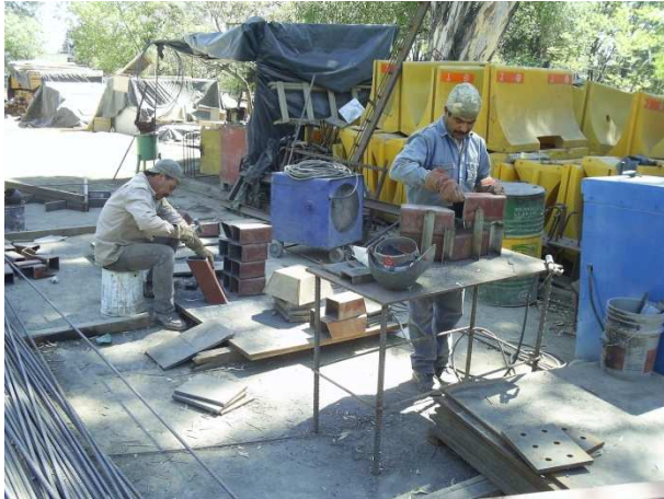
Habilitado del parapeto
