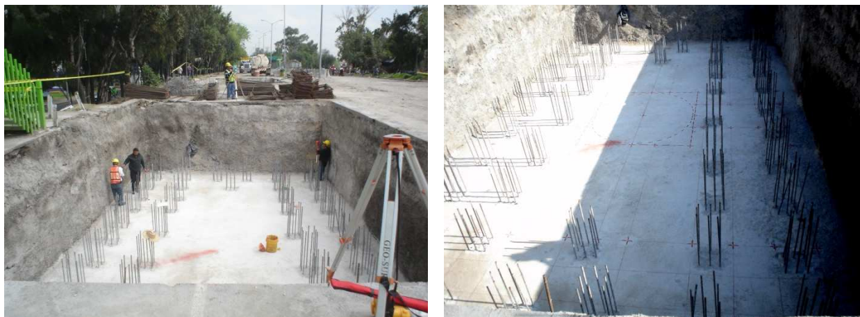
Trazo de ejes con equipo topográfico
