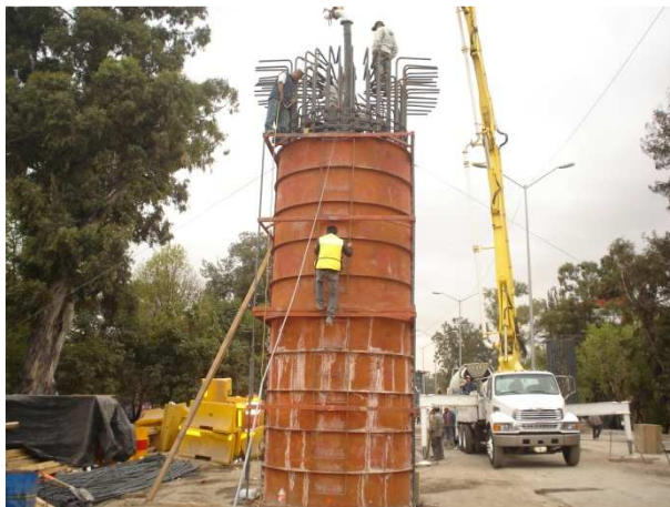
Colado de columna con bomba telescópica
