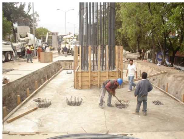
Armado y colado de losa tapa y dado de cimentación faltante
