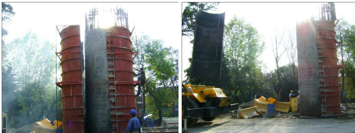
Cimbra metálica en columnas
