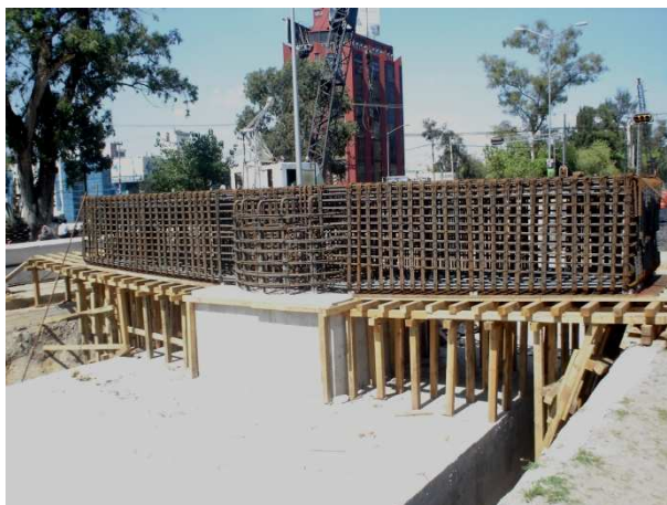
Fotografía del armado estructural del cabezal
