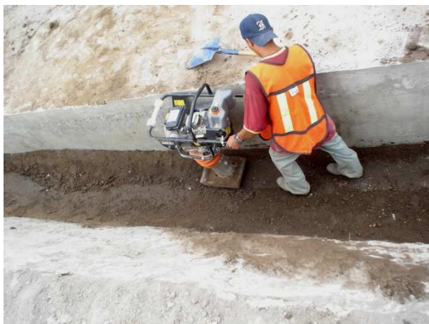
Compactación en área de zapatas
