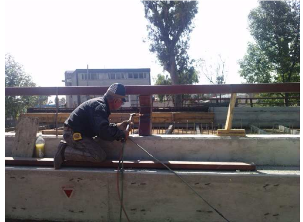
corte para colocar perfil horizontal
