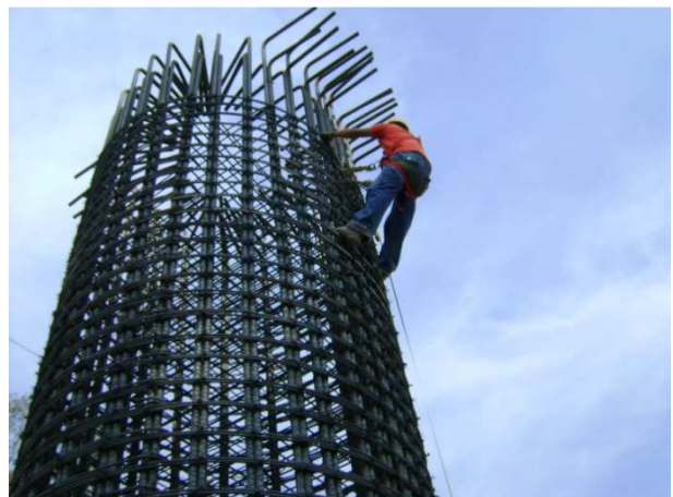
Acero de refuerzo en columnas
