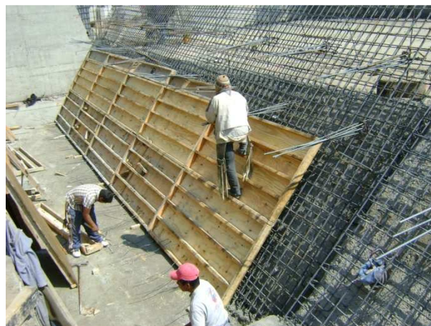
Armado estructural del muro de contención
