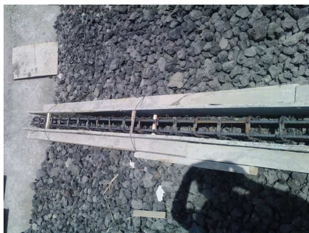
Acero de refuerzo de Tensores
