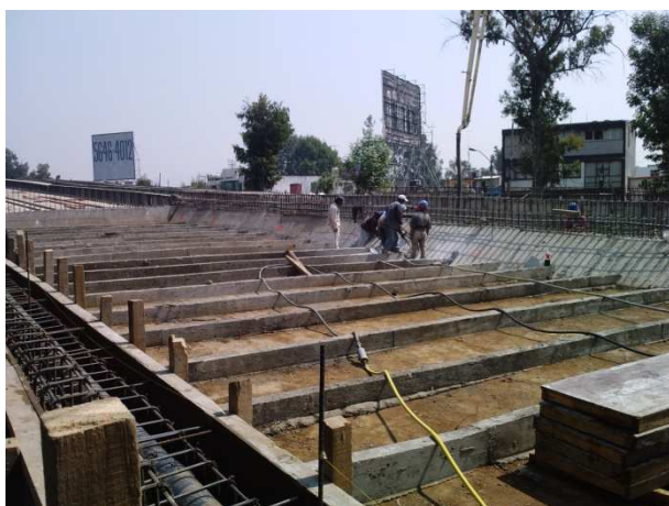
Rellenos y Tensores para liga de muros
