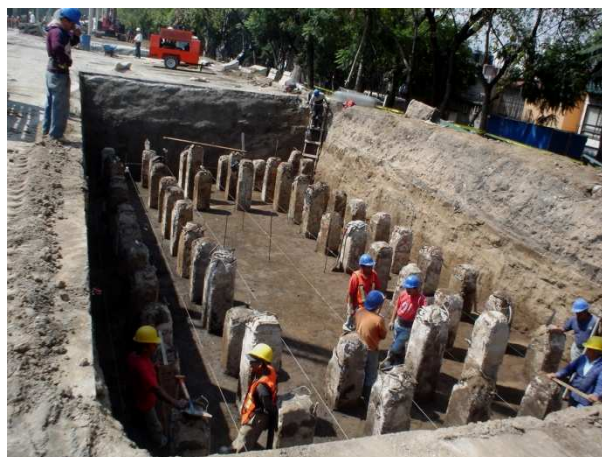
Nivelación del fondo y afine del terreno
