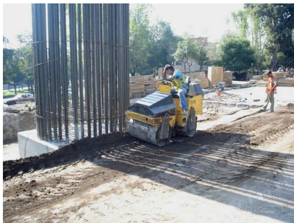
Compactación en área de zapatas
