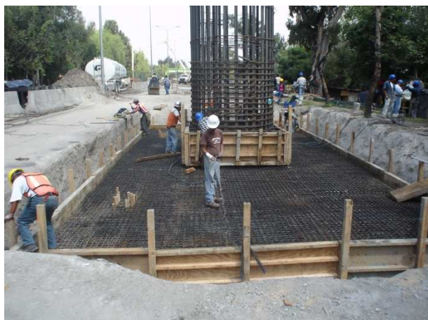
Armado y colado de losa tapa y dado de cimentación faltante
