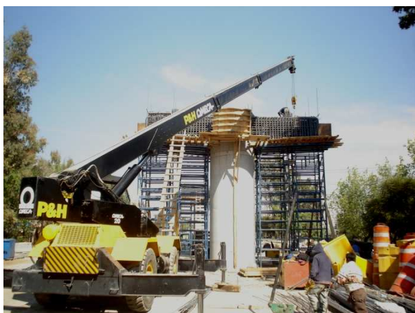
Colocación de cimbra con apoyo de grúa
