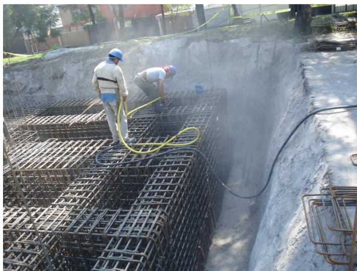
Retiro de escoria en contratraves con equipo de aire comprimido
