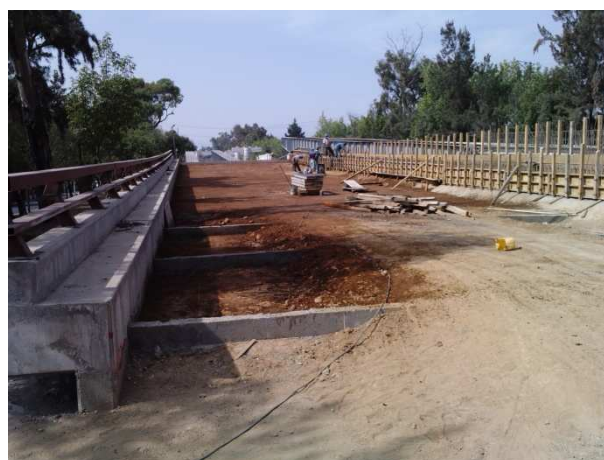
Relleno con material de banco
