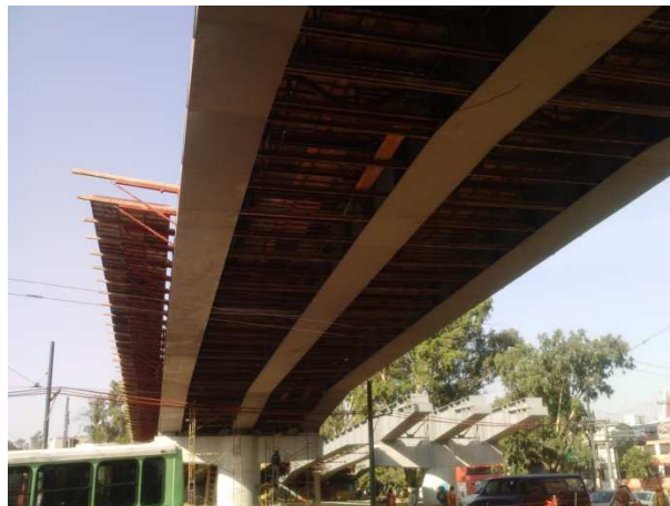
Cimbra entre traves
