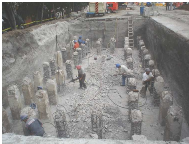
Descabezado de pilotes
