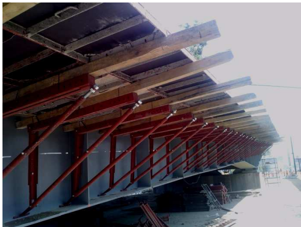
Cimbra en voladizo
