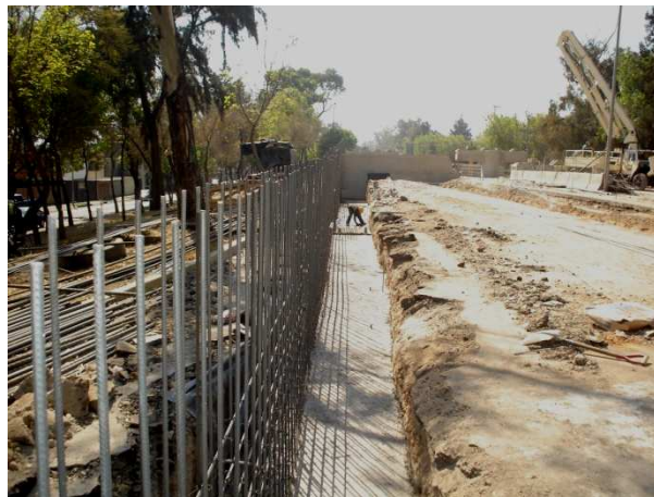
Corte del terreno para muro vertical
