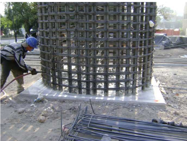
Acero de refuerzo en columnas
